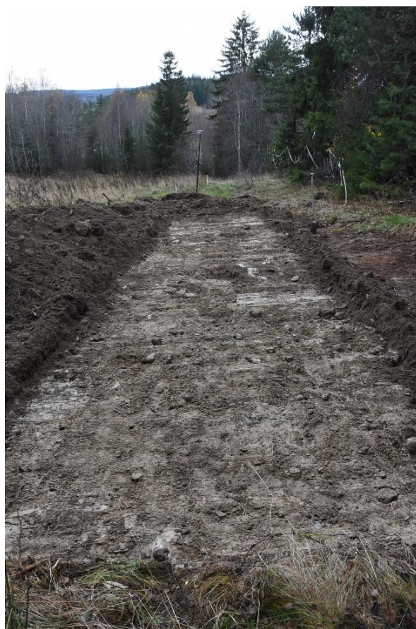
Fig. 32. Schakt 2, närmast söder/sydöst om Raä 244.
