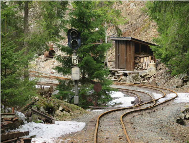
Bilde er tatt ved innkjøres signalet til Gundershogget stasjon i slutten av april 2024. Foto: Ragnar Myrvold.
