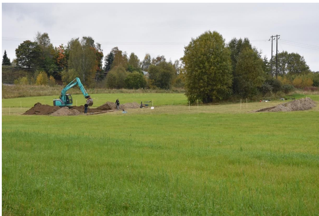
Figur 3. Översiktsbild av Raä 130 med schakt 1-3 (från vänster till höger). Foto från sydöst.
