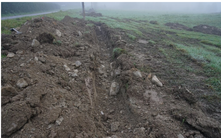
Figur 7. Schakt 2 från väster.
