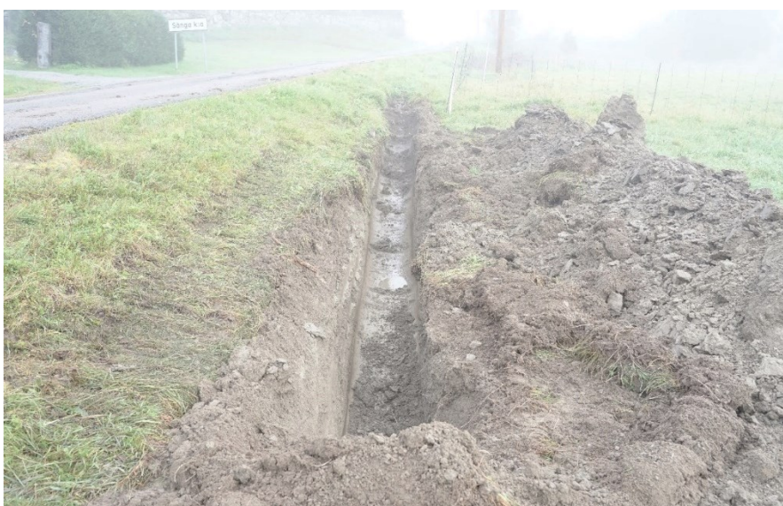
Figur 8. Schakt 9 från väster.
