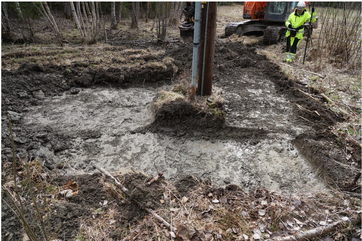
Figur 2. Schakt 1, vilket gick runt en stolpe vilken är planerad för borttagning. Taget från väst.
