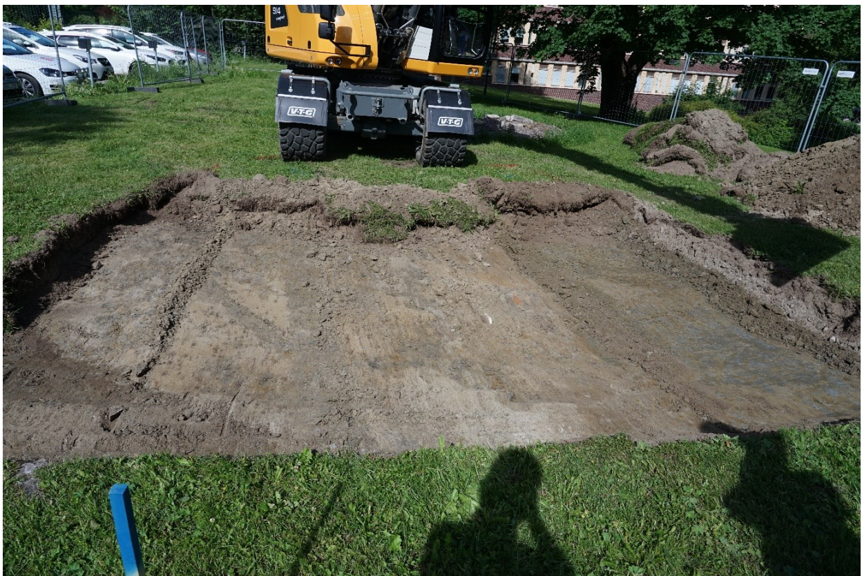
Figur 2. Schaktning utförd skiktvis, ner till det djup som exploatören behöver gå.
