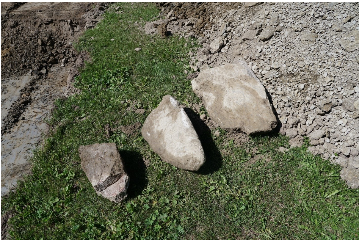
Figur 14. Stenarna efter att grävmaskinen tagit upp dem ur schaktet. Vi har rengjort dem med borste i syfte att hitta spår av stenhuggning, vilket vi ej fann. Vår bedömning är att stenarna valdes ut då de är av blockig natur.
