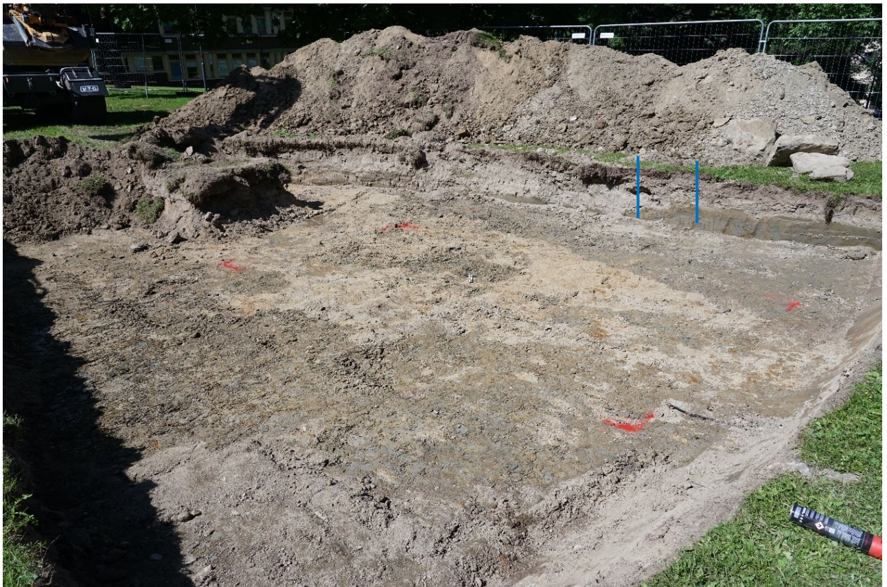
Figur 5. Första dagens schaktning. Taget från syd, med nordpil mitt i fotot. Röd färg är var elskåpet ska stå. Profiliritningen, figur 6, är ritad mellan de två blå sträcken på bilden ovan. Schaktet är här taget ner till botten på ett djup om 70 cm.
