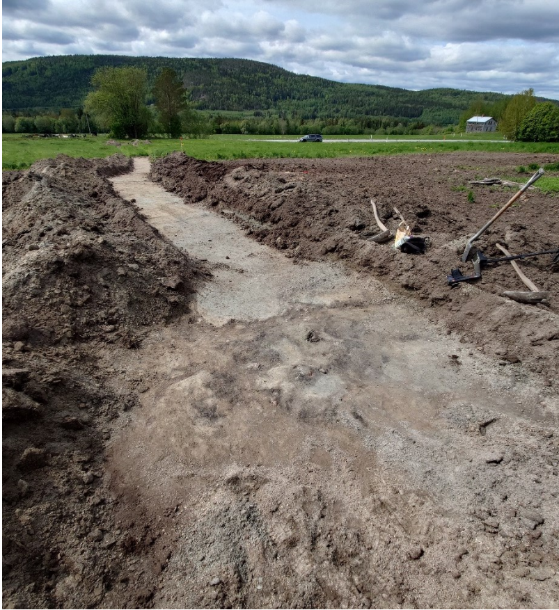
Figur 8. Schakt 6 med A7 i förgrunden. Foto från nordost.
