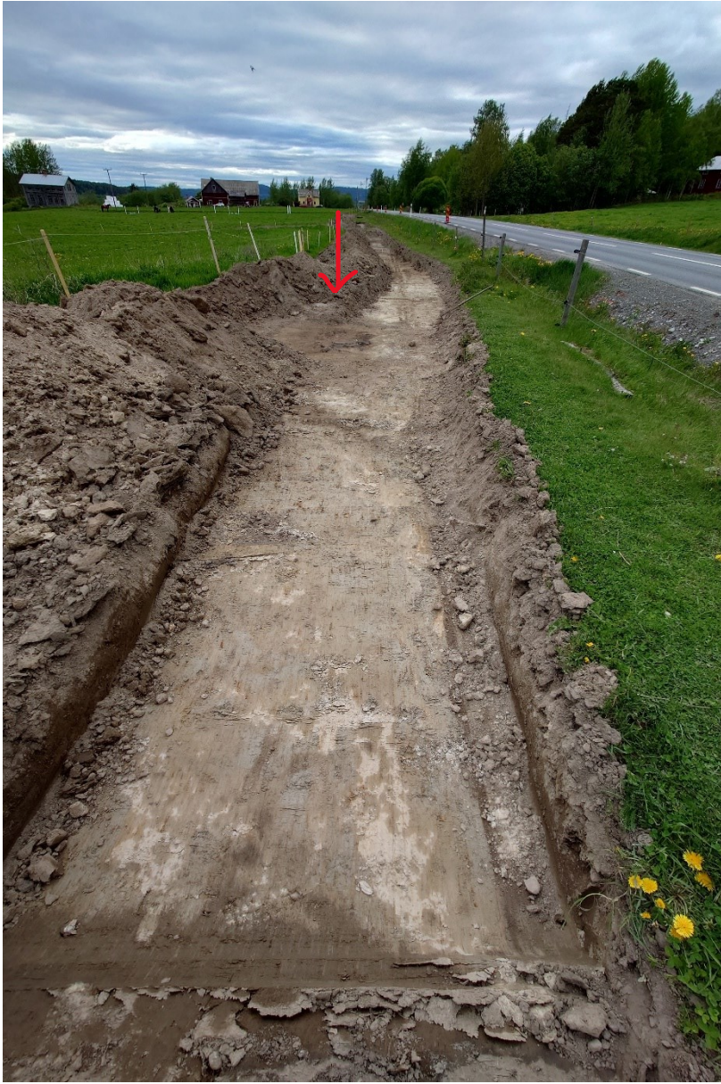
Figur 6. Schakt 1, foto från sydost. Pilen visar A1.
