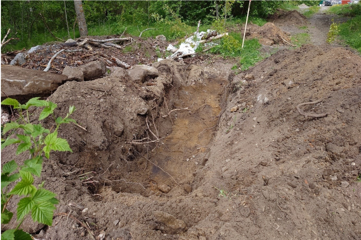
Figur 11. Schakt 13. Foto från söder.
