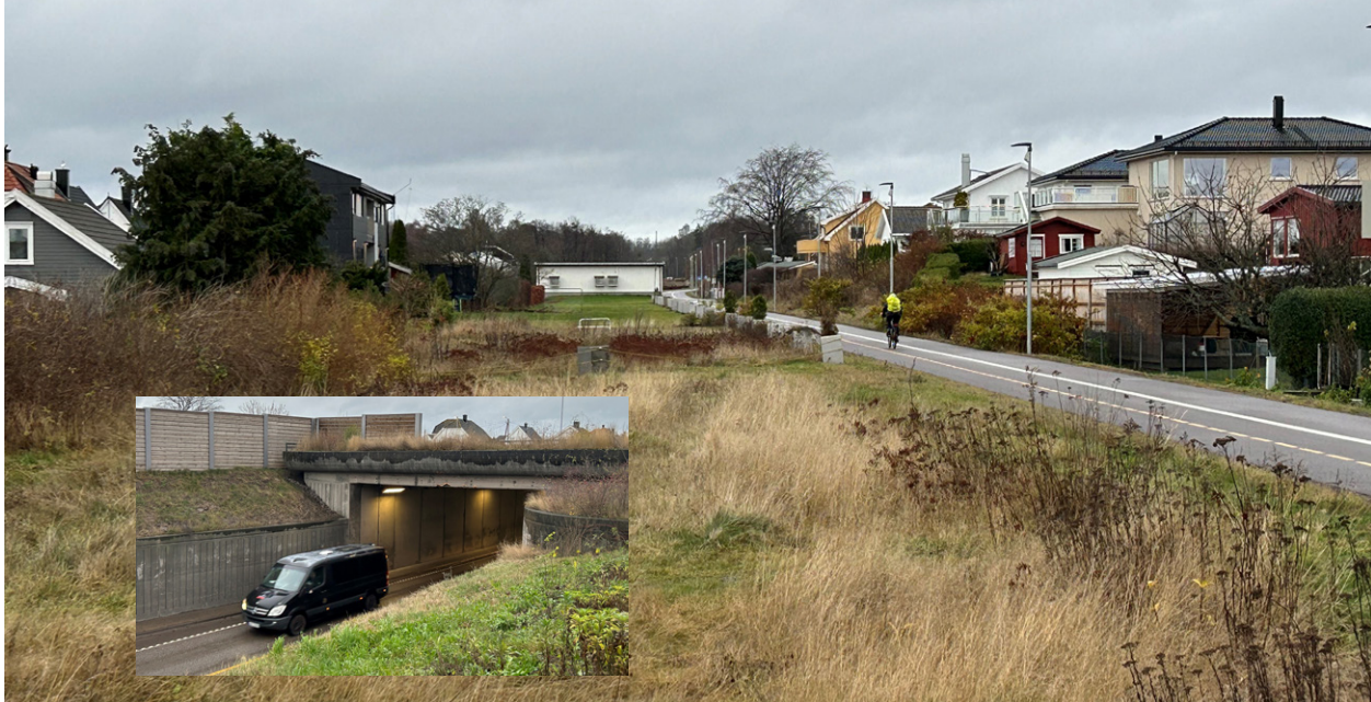
På 1990-tallet kunne vegen frem til landets travleste fergesamband, Horten - Moss, blitt bygget rett frem i bildet her. For å skåne nærmiljøet ble vegen lagt i tunnel. Hortenstunnelen er landets første «cut and cover miljøtunnel». Til høyre sykkelveg i en tidligere jernbanetrasé. (Foto: Håkon Aurlien)
