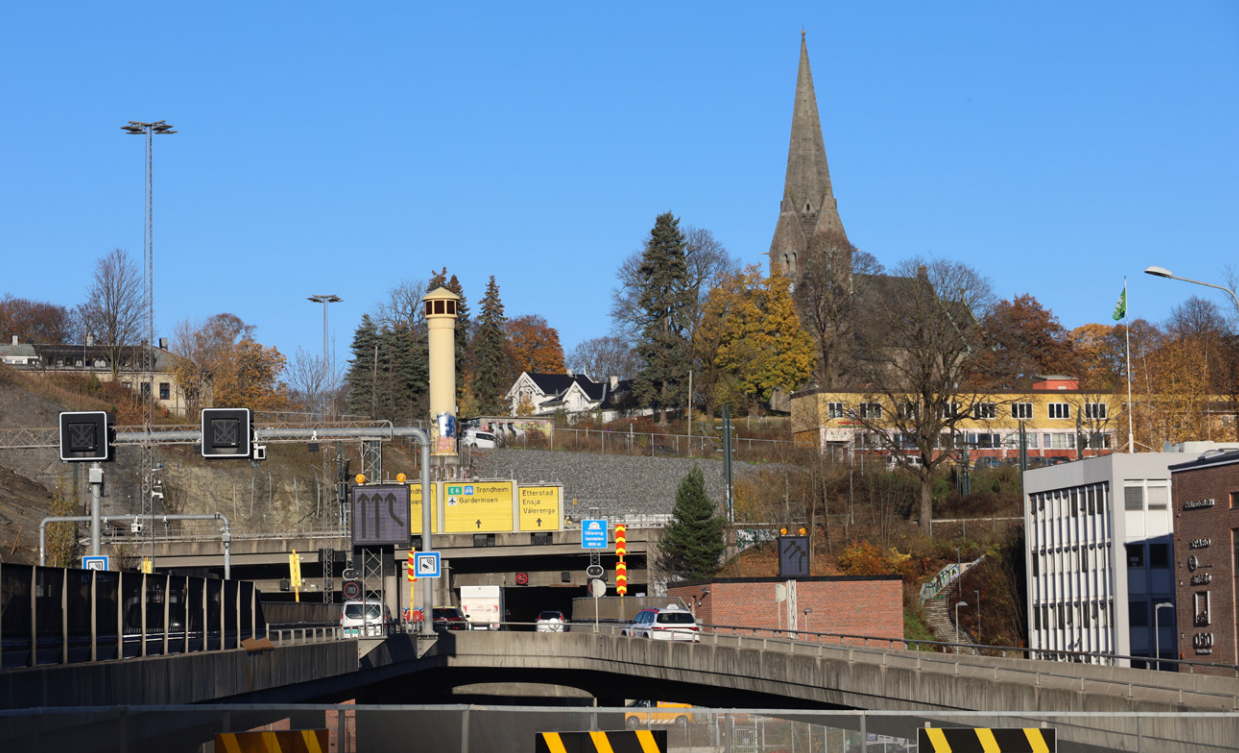
Vålerengatunnelen var første tunnel i fjell i Oslo, bygget i 1989 ut ifra et ønske om å avlaste boligområdene for ulempene med gjennomgangsstrafikk. (Foto: Håkon Aurlien)
