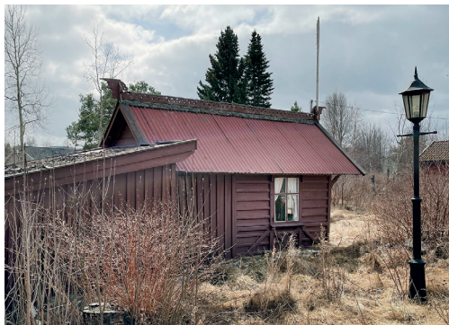
Stasjonshuset med tverrstilt påbygg slik det ser ut i 2022.
