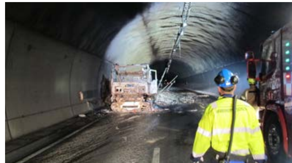
Havarikommisjonen rykker ut etter en alvorlig hendelse i en tunnel. (Foto fra Statens Havarikommisjon for transport)
