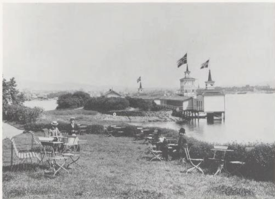
Bygdøynes bad ca. 1910. Foto: O. Væring.
