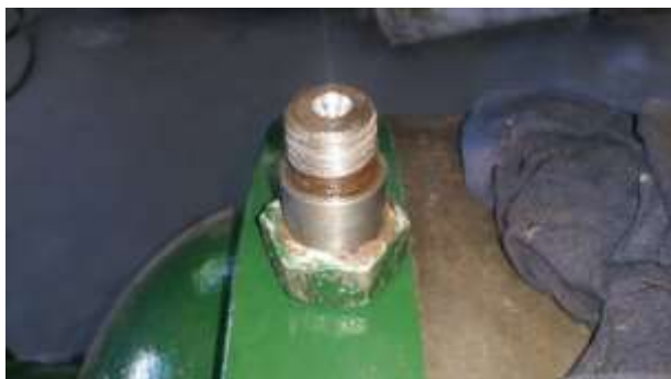
16.Bolt mellom girhendel og gir etter utbedring
