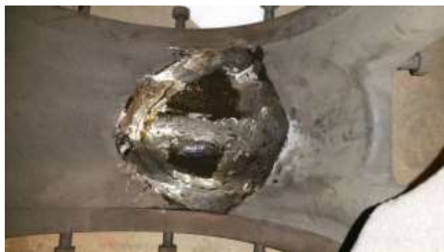
9.Veivhus innvendig etter utbedring av skade
