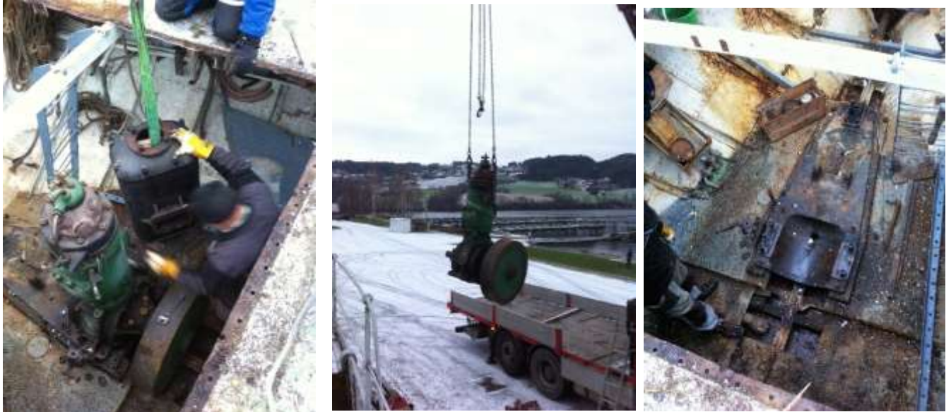
Motor ble demontert og heist ut for transport til verksted 30. nov.2014. Foto G.Johnsrud
