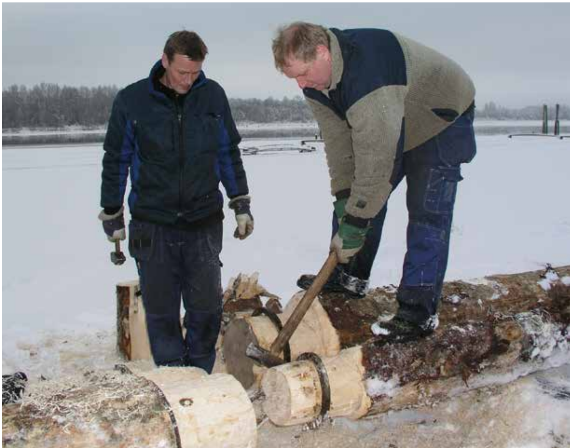
Ringene bankes på plass. Det siste stykket må Bjørn Sundbakken bruke den store slegga.
