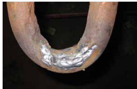
Ring forsterket med påsveist stål.
