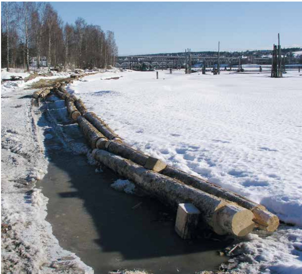
Under: 300 m doble lenser er klar til å bli slept på plass i anlegget. Dette skjer når vannstanden stiger om våren.
