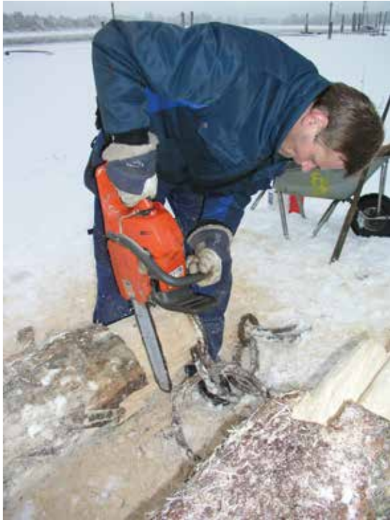
Stokken finpusses med motorsag.
