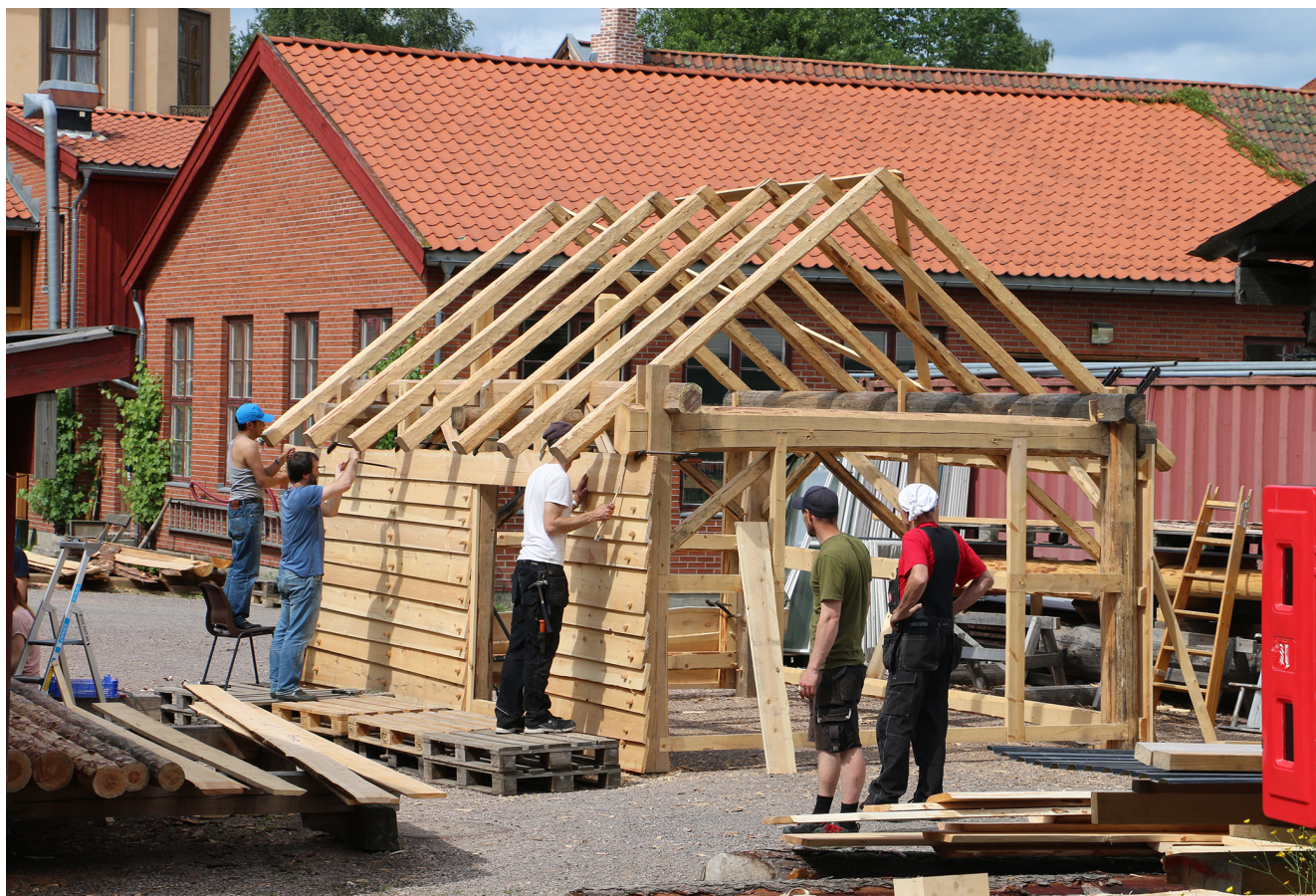
I 2016 fortsatte arbeidet med bygget. Her monteres utvendig kledning. Det bores med navar og festes med trenagler. Fra Høyre: Christiaan Winther-Larsen, Henning Jensen, John Wennberg og to studenter. Foto. Bygningsantikvarisk seksjon/Norsk Folkemuseum.
