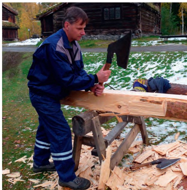
Hugging av firkantstokk. Foto: Hanne Bergseth, NHU.
