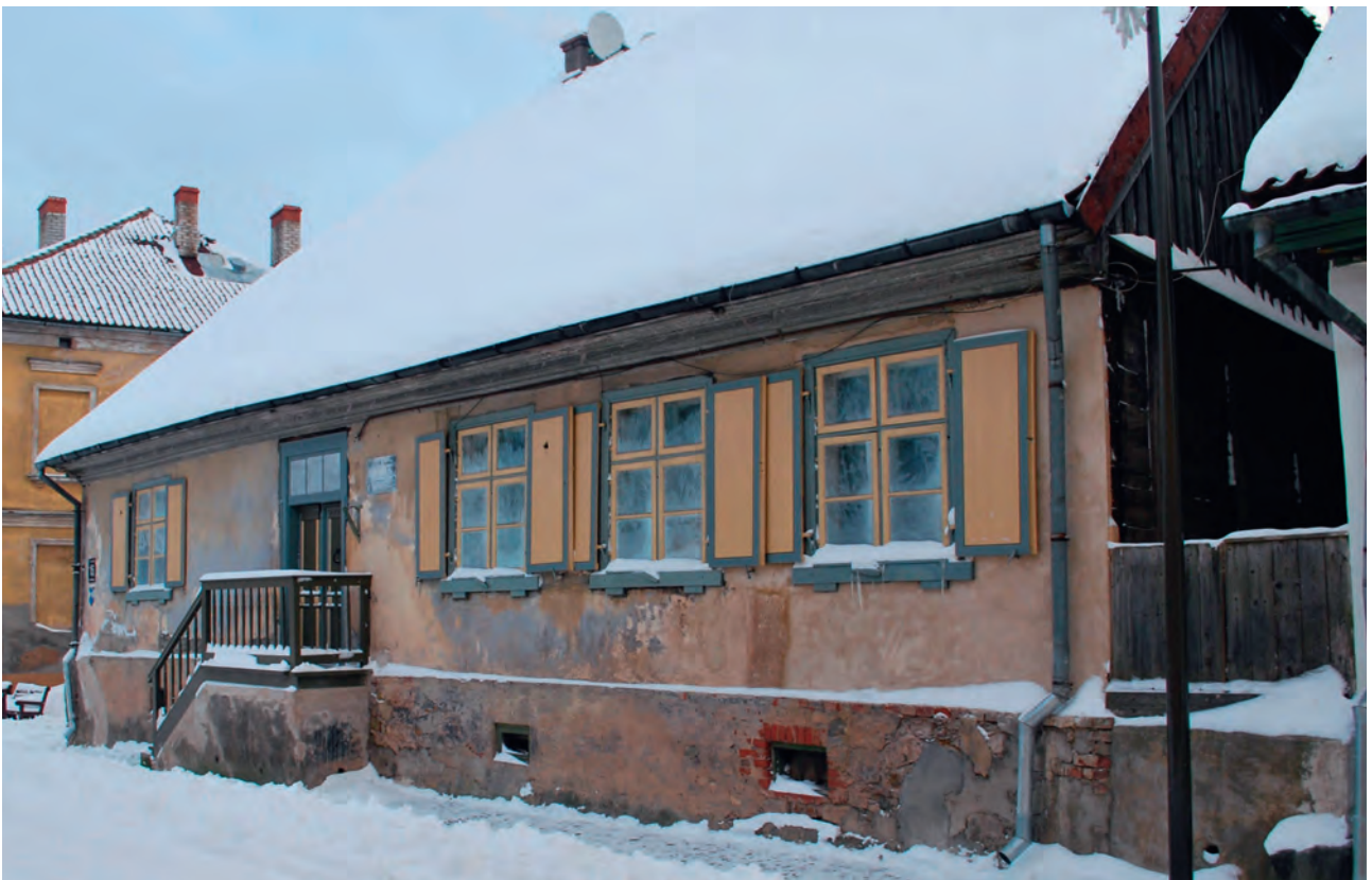
Nyrestaurert dør, vinduer og skodder i Kalna gate 15, Kuldiga.
