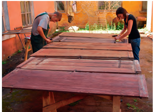
Skraping av vindusskodder. På bildet: studenter fra Kuldiga.
