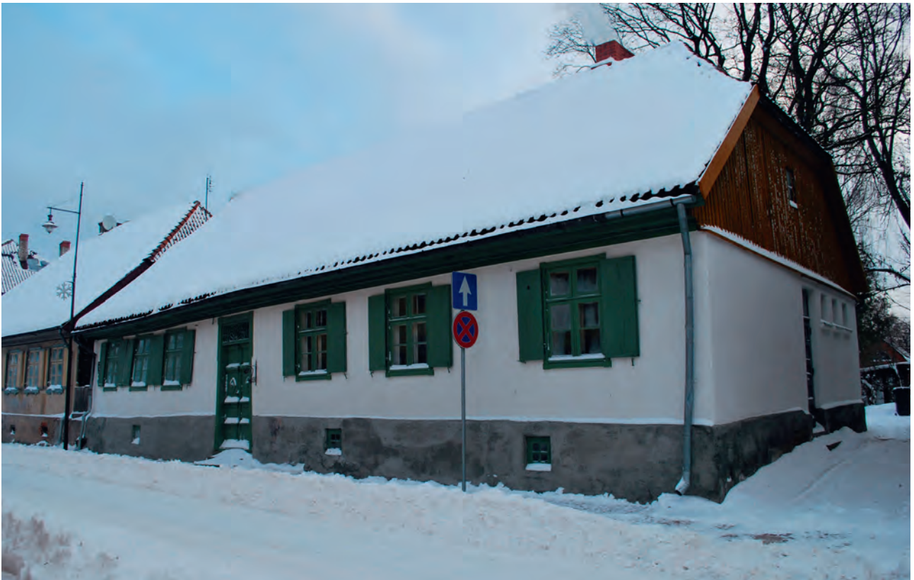
Kalna gate 13, nyrestaurert dør, vinduer, skodder og vegg.
