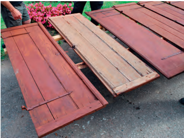
Vindusskodder til Baznica gate 28, grunnet.
