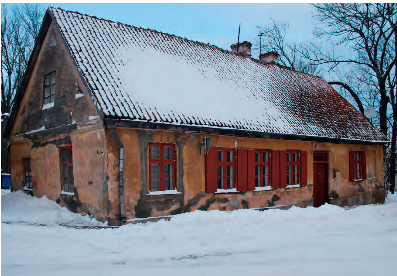
Baznica gate 28, restaurert dør, vinduer og skodder.
