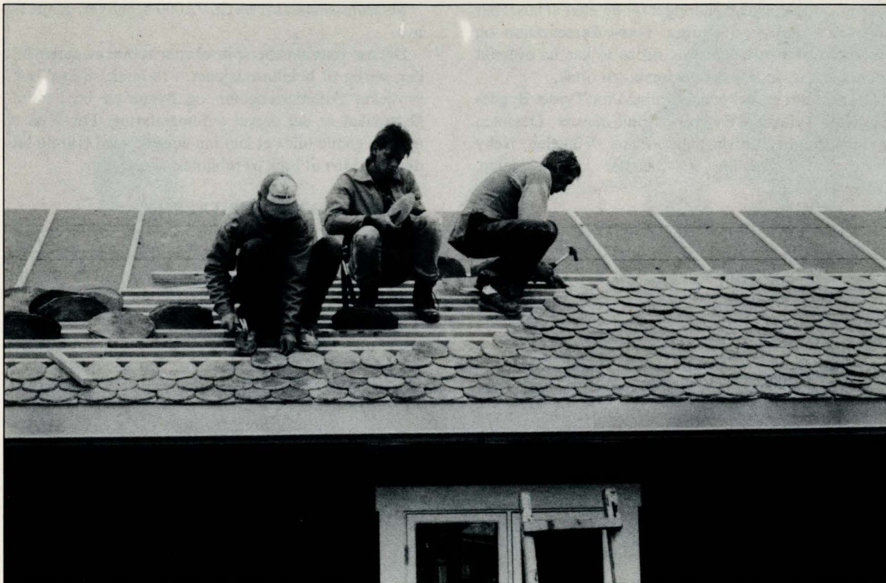
Skifertake legges på det nye verkstedet på Ramsmoen, f v: Morten Rønningen, Stein Holm og Egil Nordli. Huset inneholder arkiv, lokalhistorisk arbeidsrom og snekkerverksted (70838)
