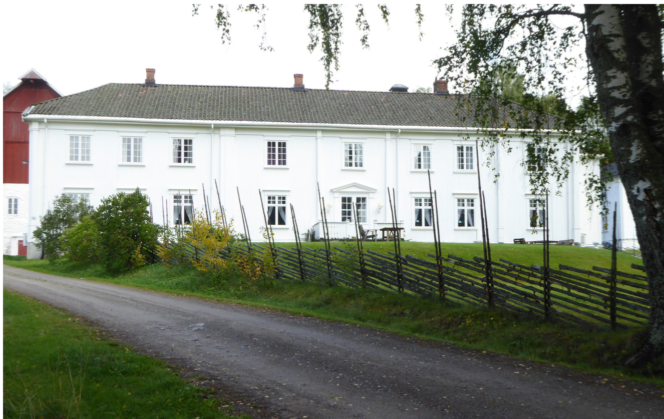
Hovedbygningen på Sønsterud sto ferdig kort før 1790, som en av de største og mest påkostede i Solør. Bygningen fikk nye vinduer og nytt utvendig panel tidlig på 1900-tallet. Foto: Geir Thomas Risåsen, Norsk Folkemuseum.
