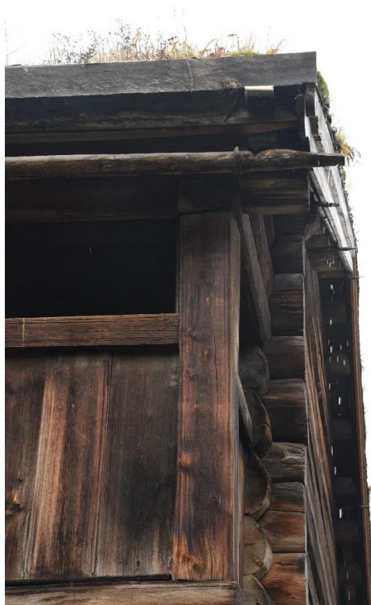
Maihaugen har og ein del takrenner i tre.
