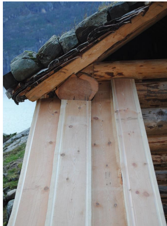
Godt adla takbord i fallande breidder med retthøvla overslag og ukanta underslag. Foto: Ryfylkemuseet.
