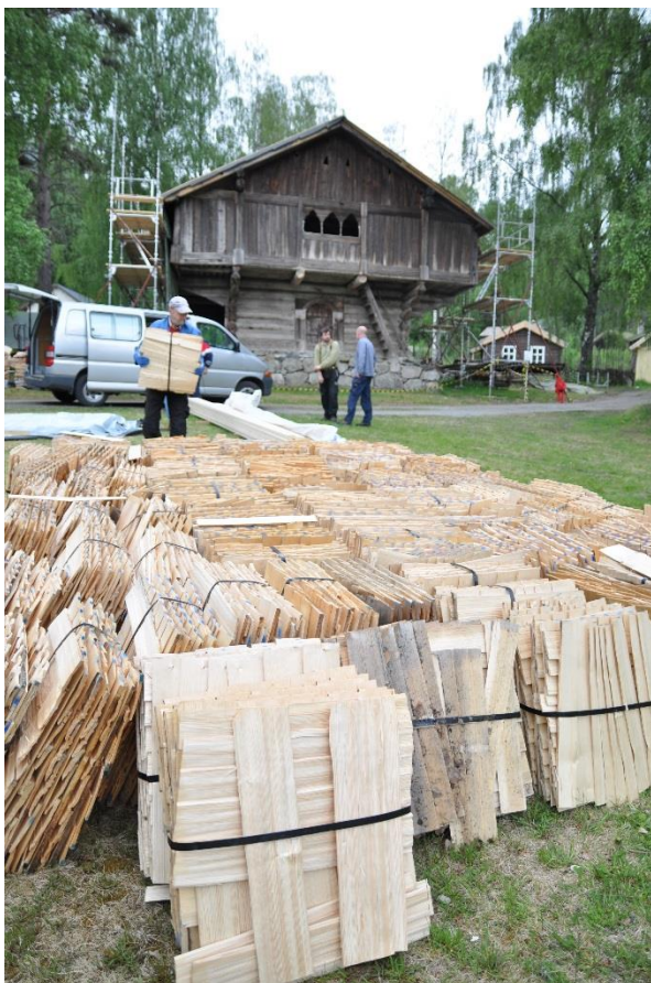
Torvtaket på Staveloftet (1340) på Hallingdal folkemuseum blei skifta ut med stikker i 2011. Foto: Hallingdal folkemuseum.
