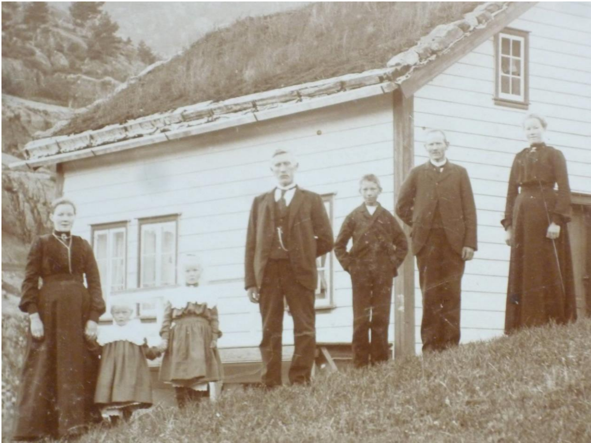
Dette er familiane Vårvik og Fisketjøn som er fotograferte framfor huset sitt i 1903. For oss er det interessante med bildet at det er takrenne langs heile raftet på huset. Arkivfoto: Ryfylkemuseet.
