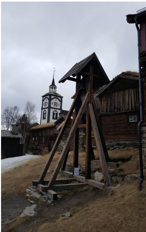
Etter 230 år var det ikkje behov for å skifte ut meir enn 1% av spona på Røros kyrkje.
