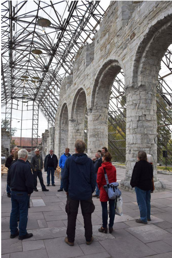
Frostsprenging var i ferd med å ta knekken på restane av domkyrkja på Hamar. Løysing blei eit vernebygg i glass.
