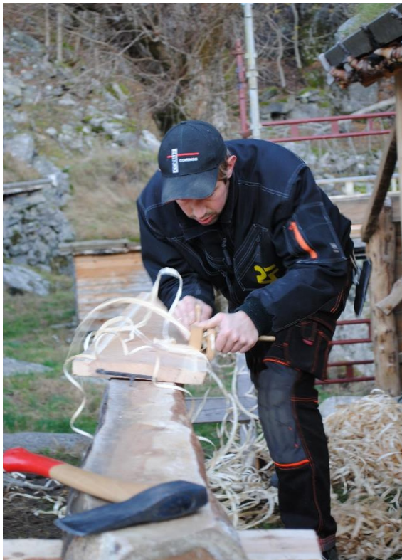
Vassrenna i underslaga blei høvla på frihand etter snorslag. Sven Hoftun, driftsleiar. Foto: Ryfylkemuseet.
