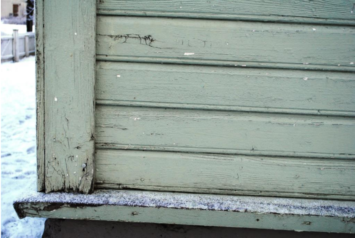
Hundre år gamal originalkledning tredve år etter sandblåsing. Foto: Ryfylkemuseet.
