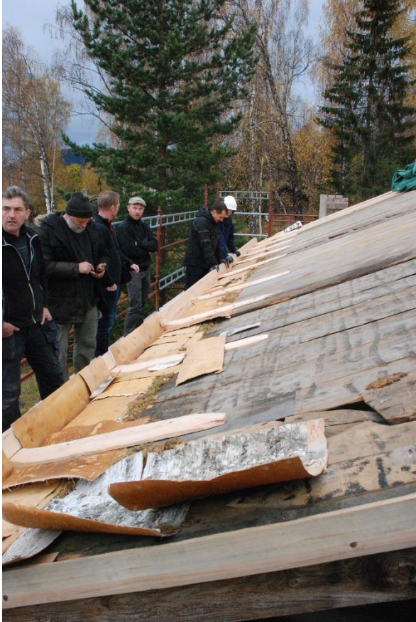
Tekking med never på Isum, Maihaugen. Foto: Norsk håndverksinstitutt.
