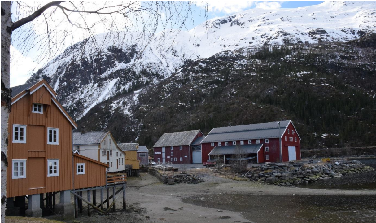
Helgeland museum har eit fantastisk utgangspunkt for eit flott hovudsete i det gamle Mjåvatn-anlegget (dei raude bygningane bak i bildet), men golvet ligg under forventa havnivå ved framtidig stormflo.
