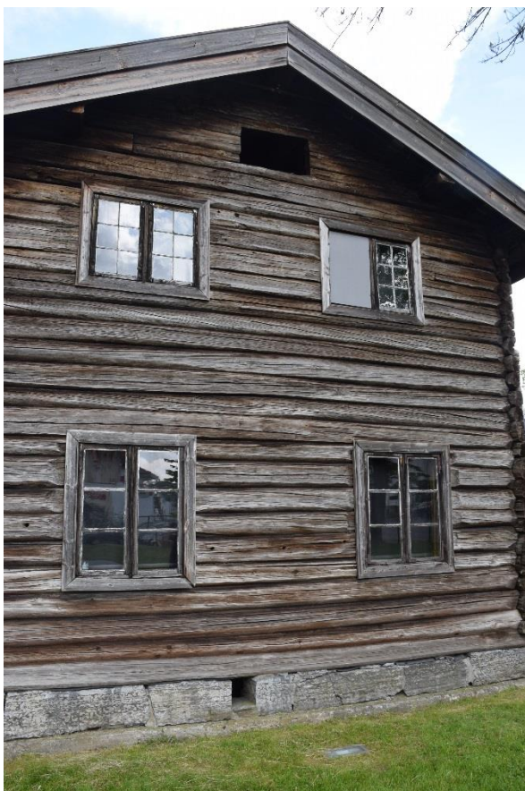
Vedlikehaldet av Rambergstua (1750) i Brekkeparken på Telemark museum er blitt hengande etter. Det er særleg glasa som har fare ille.
