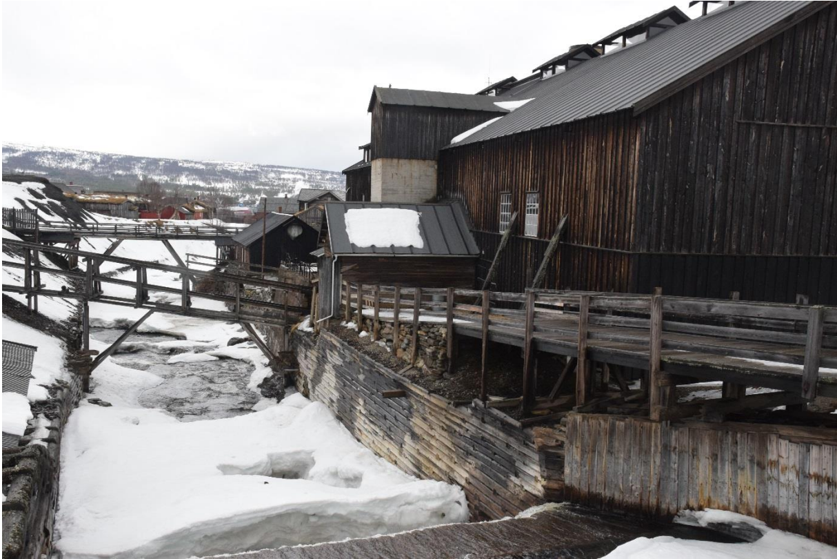
Ved Røros museum har dei ansvar for ei mengde installasjonar med tømmer som står i vatn. Her frå elveforbyggingar ved smeltehytta i Røros.
