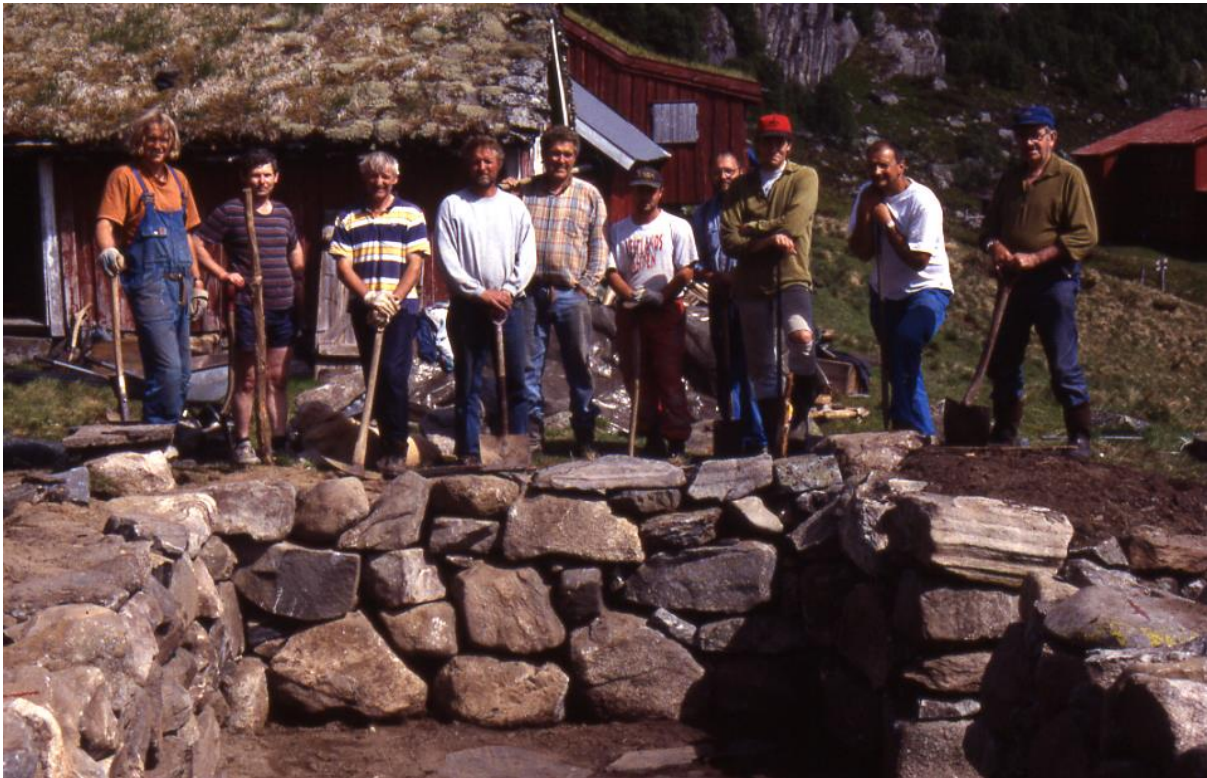
Tørrmuring av grunn til stølsfjos på Sandsa i Suldal. Arbeidsleiar Per Surnevik med ruta skjorte i midten, tradisjonsberar Albert Moe til høgre, Espen Marthinsen, seinare stipendiat og svært kunnig murar, som lærevillig deltakar heilt til venstre. Foto: Grete Holmboe, Ryfylkemuseet.
