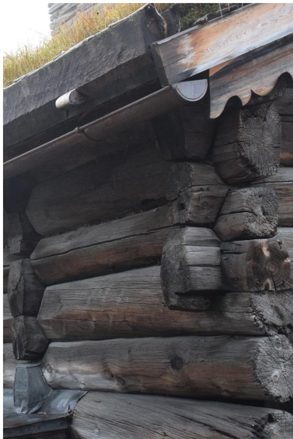
På Maihaugen har ein vald å bruke takrenner av kopar på ein del tak. Dei blir nokså fort mørke og lite synlege.
