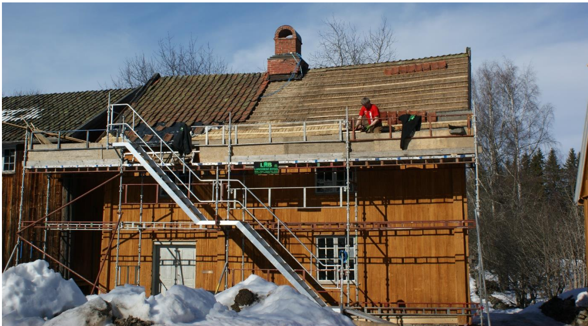
Da taket på Drengstua på Stenberg, Mjøsmuseet, måtte reparerast, restaurerte museet undertaket av flis ved å legge ny flis. Foto: Mjøsmuseet.
