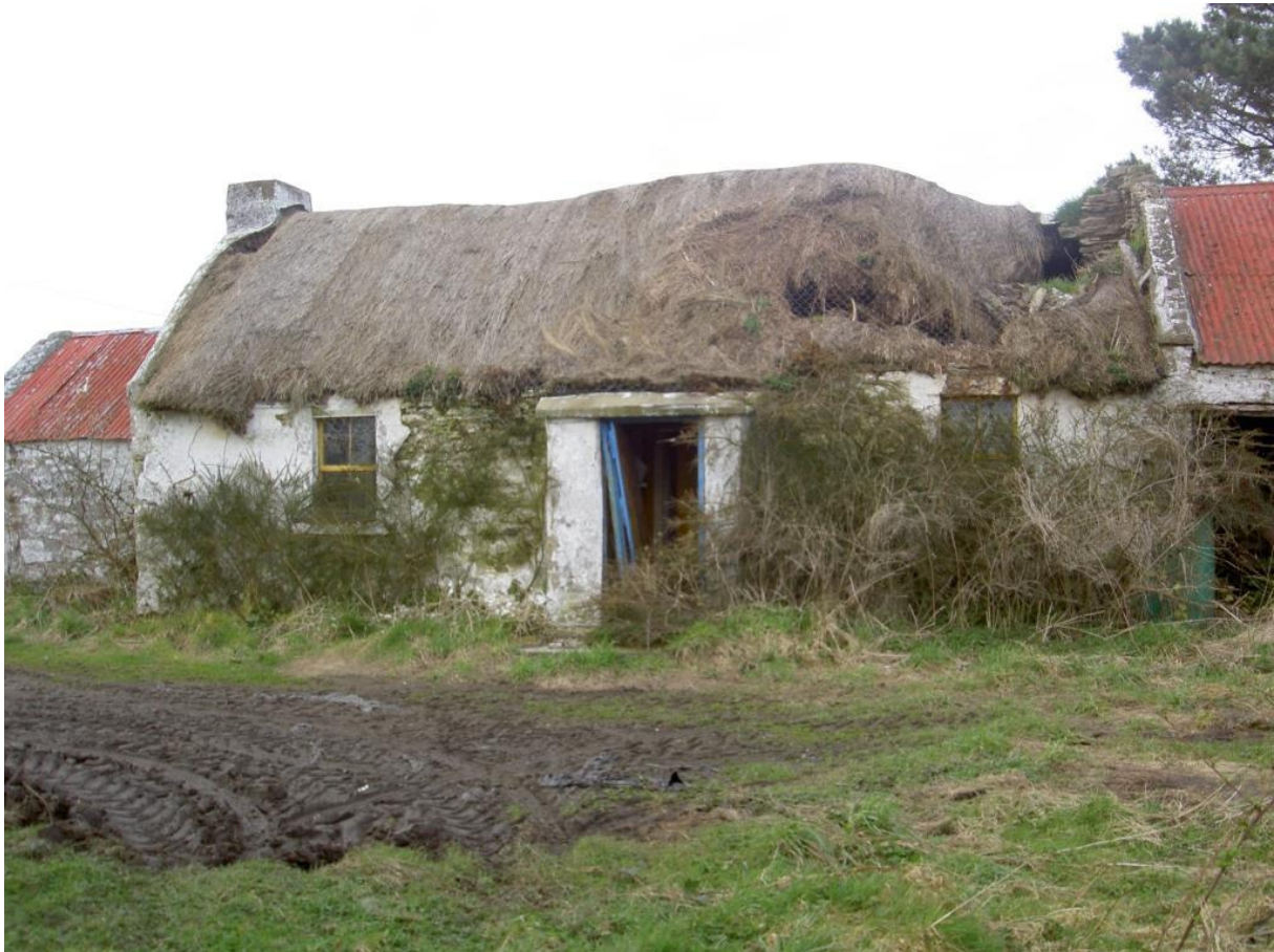
Kva klimaet gjer med stråtekte hus i Irland. Pat's hus fotografert i 2009, eit par-og-tjuge år etter bildet på første side. Pat har i mellomtida gått ut av tida. Foto: Brian S. Turner.
