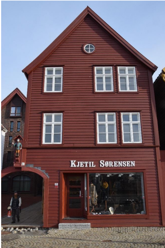
Nyoppussa fasade på Bryggen i Bergen. Stiftelsen Bryggen legg stor vekt på tradisjonshandverk både i arbeidet med bygningane og i overflatebehandlinga.
