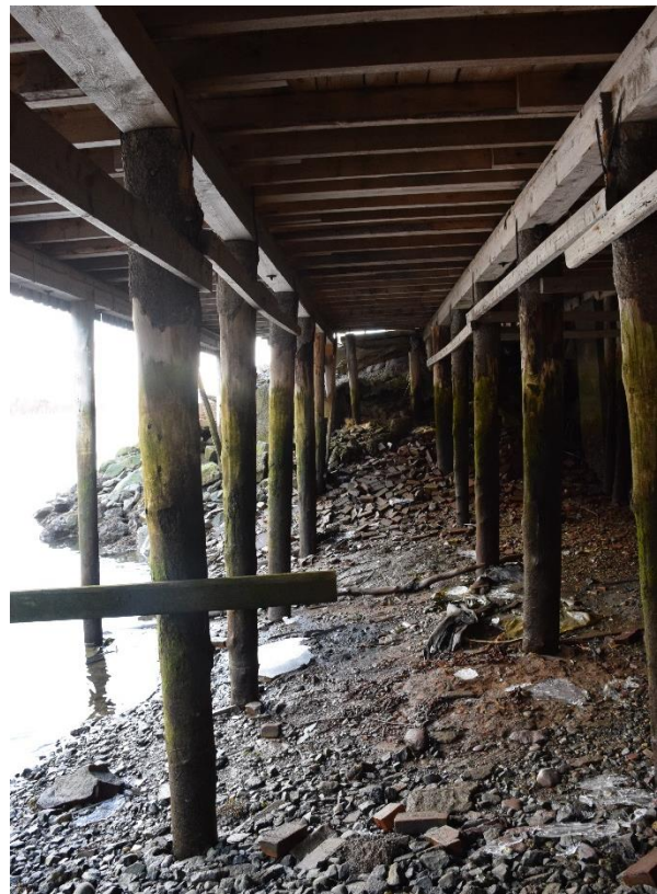
Auka førekomst av mildver og isgang i Vefsna om vinteren trugar fundamenta under bryggene.
