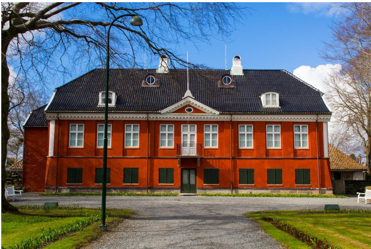
Lyststaden og kongebustaden Ledaal i Stavanger med fasade i nypussa kalkmørtel, etterbehandla med kalkmaling. Foto: Museum Stavanger.
