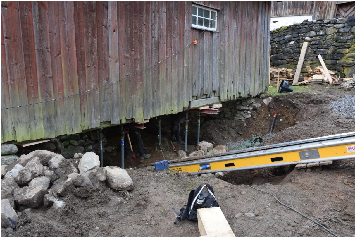
Omfattande arbeid med restaurering og drenering av ostekjellaren under skålen på amtmannsgården Stenberg, Mjøsmuseet.
