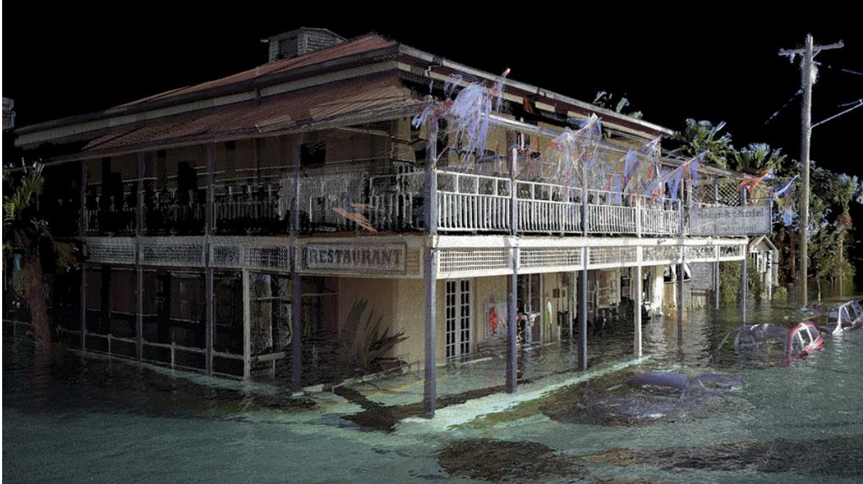
The Iland Hotel, Cedar Key, Florida (1859) er eit av dei objekta som er dokumentert ved hjelp av 3-D laser for å kunne visualisere konsekvensar av auka havnivå. Foto: Sujin Kim, University of Florida.
