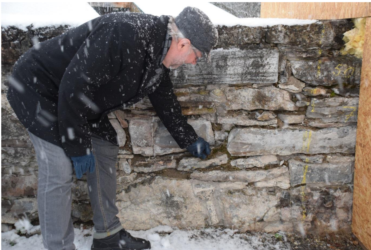
Middelaldermur i dårleg ver. Tor Sæther viser fram. Det går føre seg eit omfattande program på Domkirkeodden for å reparere middelalderruinar, m.a. ved ei møysamleg utskifting av sement med kalkmørtel.
