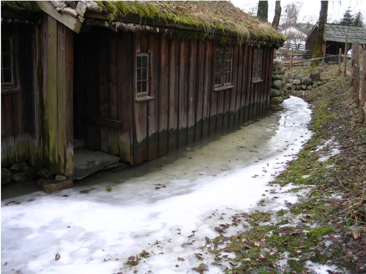
Norsk Folkemuseum på Bygdøy står i eti nedslagsfelt utan tilstrekkeleg avlaup. Bildet er frå baksida av Jærhuset før det blei gjennomført drenering av området. Foto: Norsk Folkemuseum.
