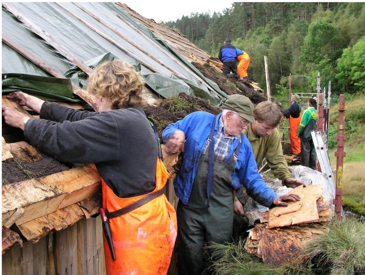
Vidareføring av tradisjonskunnskap skjer når unge arbeider saman med eldre tradisjonsberarar. Her frå tokedugnad på Hustveit, Sauda. Foto: Ryfylkemuseet.
