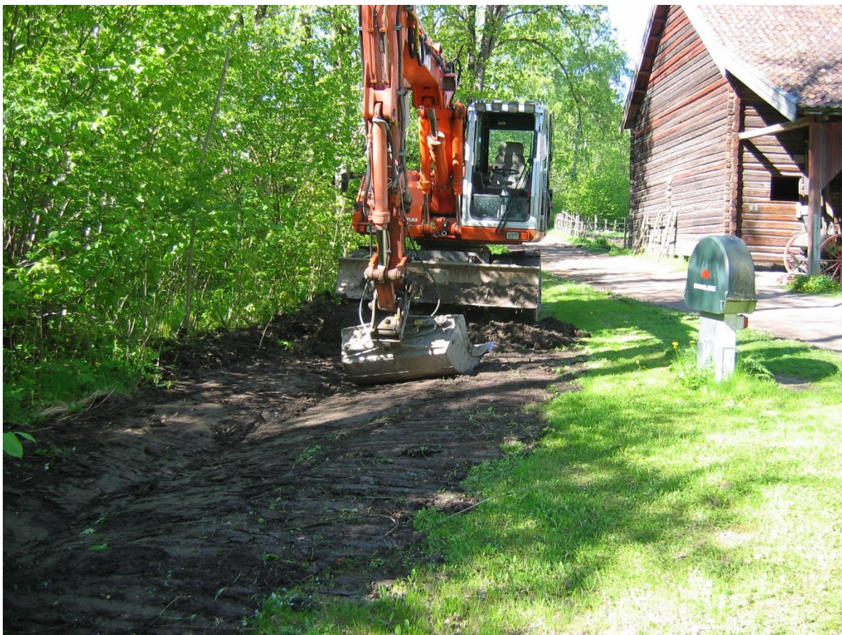
Gjennom forsiktig bearbeiding av terrenget avhjelper Folkemuseet noe av overvassproblema, men det er behov for eit større dreneringsarbeid for å møte aukande nedbør. Foto: Norsk Folkemuseum.
