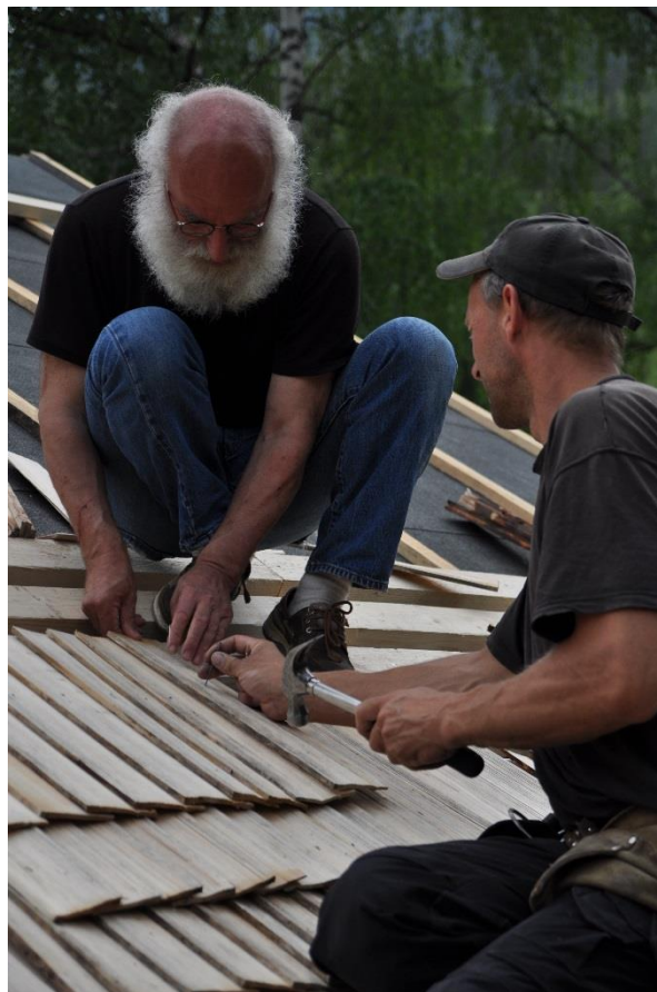
Anders Haslestad frå Riksantikvaren og Jørn Berget i ferd med å feste stikker på Staveloftet. Foto: Hallingdal folkemuseum.
