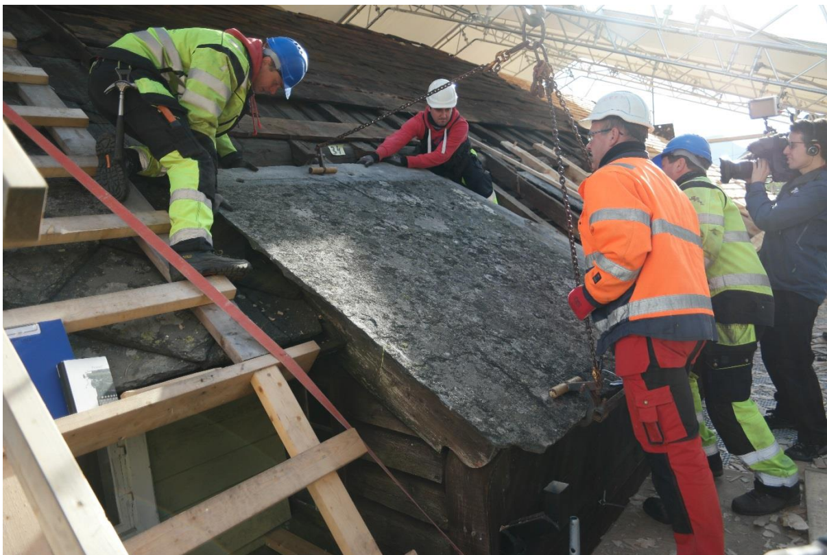
Legging av store heller på Lagmannstova, Aga. Det var byggmeister Haakon Kvestad, eit firma som har spesialisert seg på slikt arbeid, som hadde ansvaret for jobben. NRK filmar til innslag i Norge Rundt. Foto: Hardanger og Voss Museum.
