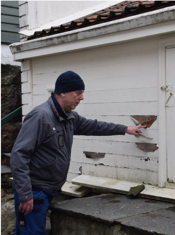
Når konstruksjon, måling og klima spelar på lag. Dag Jenseg viser at dei har store utfordringar på Gamle Bergen Museum.
