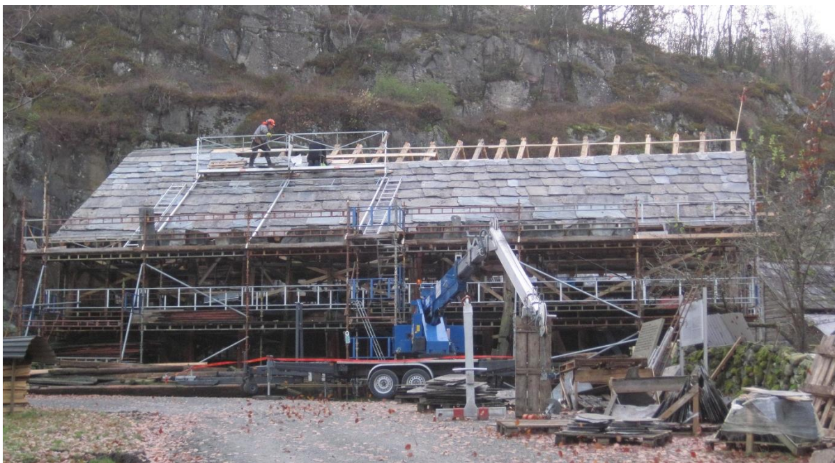
Helletak på løa i Viga, Hjelmeland, under omlegging. Foto: Grete Holmboe, Ryfylkemuseet.
