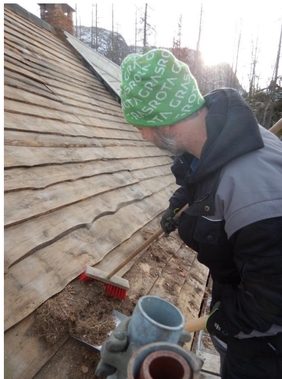
Sua undertak på hovudbygningen på Håland i Erffjord. Foto: Ryfylkemuseet.
