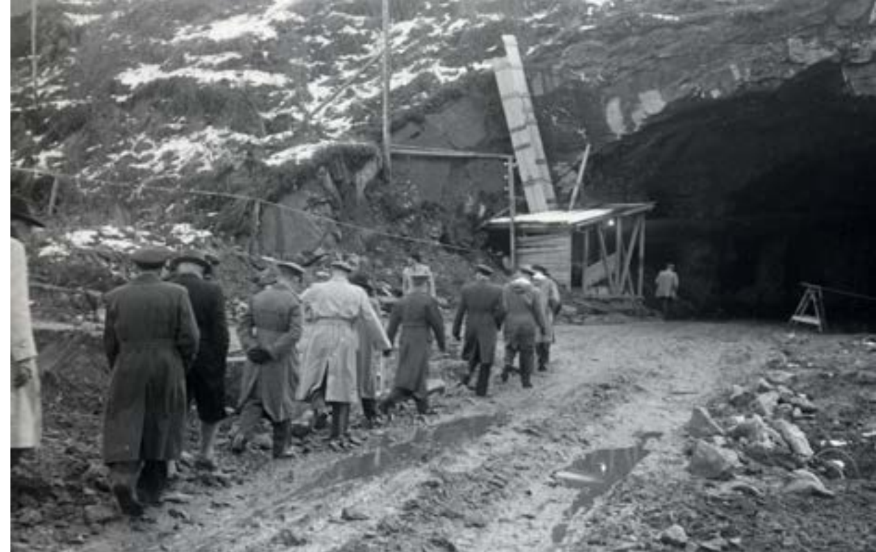
Ledelsen av Luftforsvaret under befaring i en «atomsikker» fjellhall ved Bardufoss flyplass 1953. (Foto: Ukjent).
