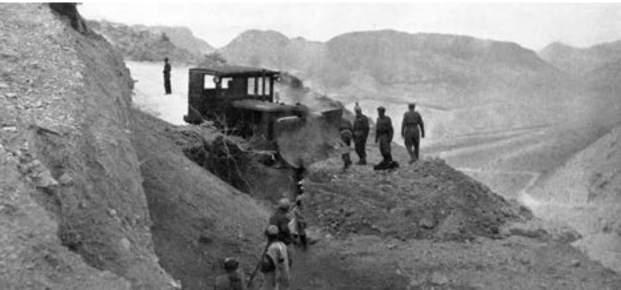
Med bulldozer repareres en utrast veg. (Foto fra Paiforce).
