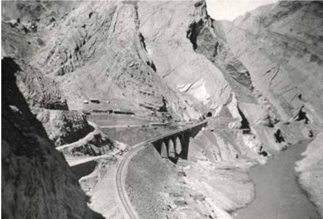
Et foto fra byggingen av den trans-iranske jernbanen i fjellområdet i nord. Det viser tilkjøringsveier, jernbanetraseen og tunneler i tillegg til brakker for arbeidsstokken. (Foto fra Kampsax).
