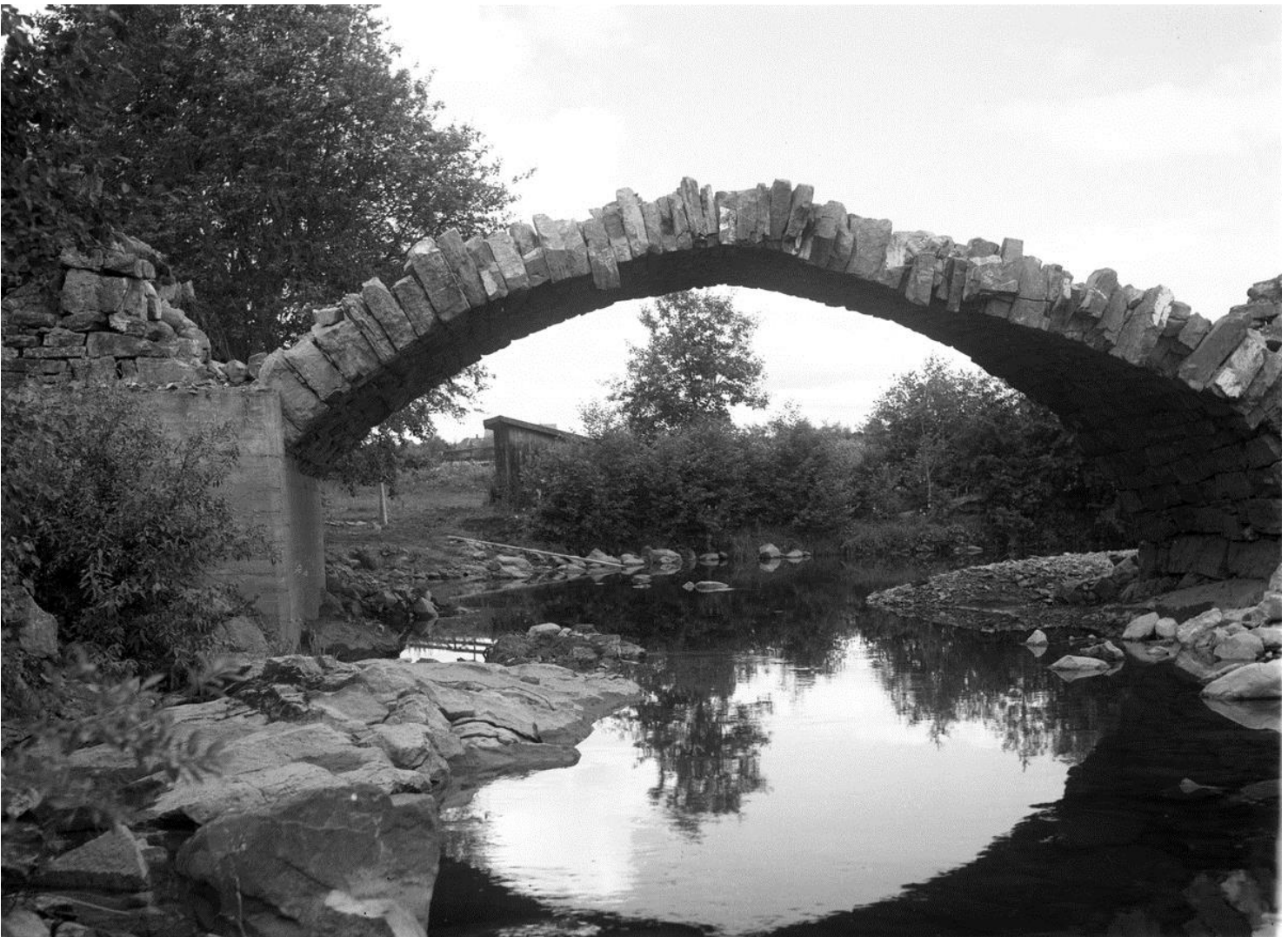
Steinbrua over Lenaelva ved Håjen, Lena, ant. 1936-38. Foto: Sigurd Bernhard Røisli, Mjøsmuseet, TMF-02176
