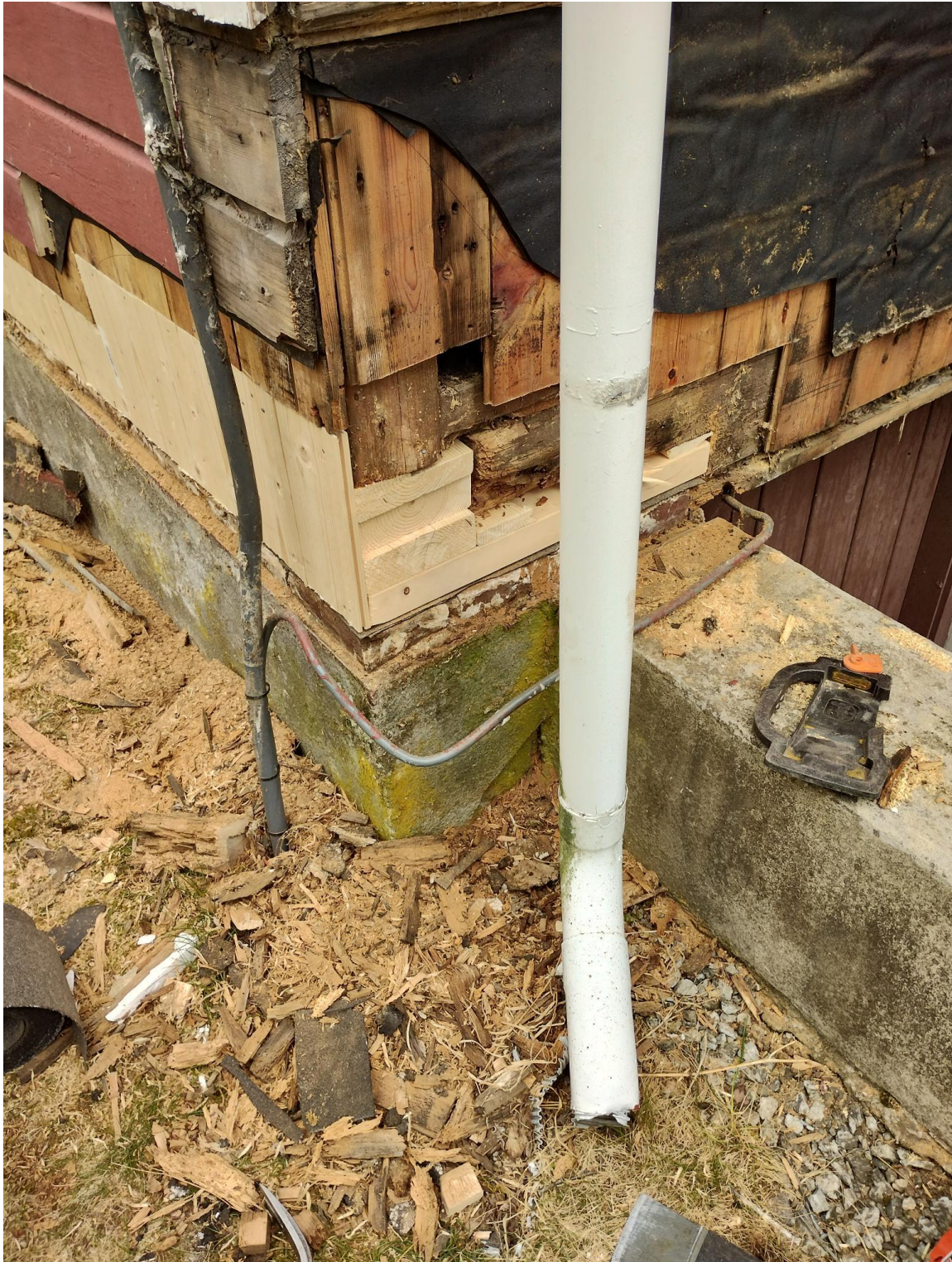
Bygningsarbeid i Folgefonngata. Foto: Svein Jåstad, Kraftmuseet
