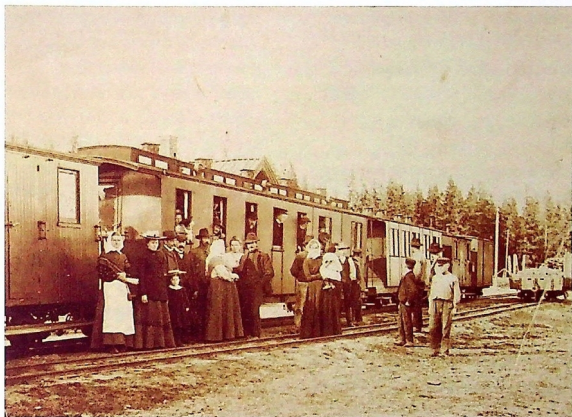
Hjellevøl stasjon i september 1905, trolig i forbindelse med mobiliseringen.
