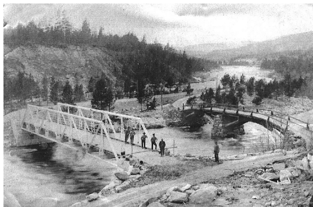
De eldste bruene over Einunna. T.v. stålbrua som vart sprengt i april 1940. T.h. den gamle brua fra om lag 1860, som Morten Mortensen stod for bygginga av. Fotoarkiv: Grimsbu Gard- og Grendeutvikling.
