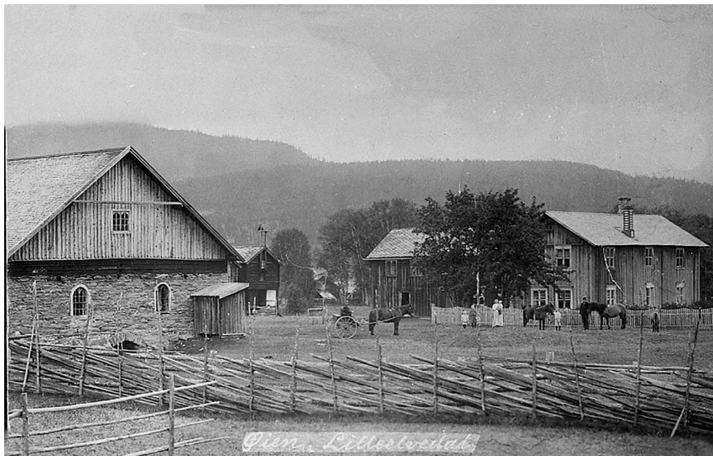
Øien (Hagerupsøya) i Alvdal omkring århundreskiftet eller aller først på 1900-tallet. Det store steinfjøset Morten Mortensen bygde t.v og den nye stua han satte opp er trolig den t.h. Foto: trolig Henrik Stinessen. Fotoarkiv: Musea i Nord-Østerdalen, nr. minø.037077.
