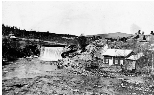
Kraftstasjonen ved Tunnfossen. Her lå Forsøgets Brug, bygd opp fra 1843. Inntil fossen på høyre side ses rester etter mølle og stampe, og oppi bakken t.h. lå sagbruken. Kraftstasjonen vart satt i drift aller sist på 1897. Fotoarkiv: Musea i Nord-Østerdalen, nr. min0.023643.
