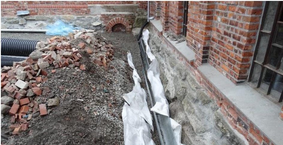
Tiltak for å lede bort overflatevann og takvann ved nordvegg til Luthuset i september 2020.
