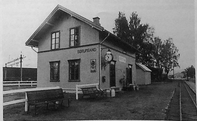
Med utedoen på plass er Sørumsand st. nærmest komplett.
