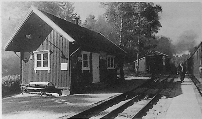
Bygningene på Bingsfoss ble malt opp i rødt med hvite vindusrammer.
