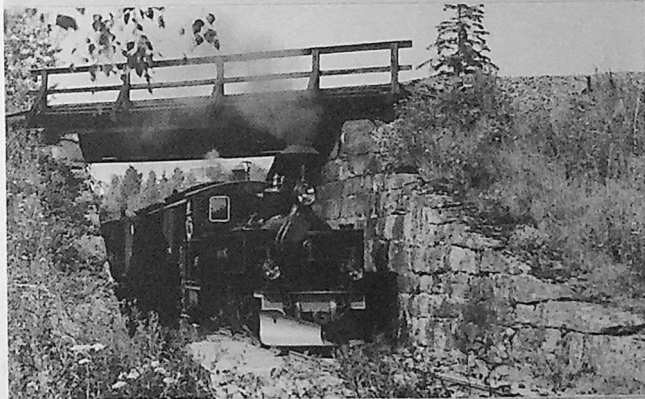
"Seiskogen" ved undergang Kongsvingerbanen.
