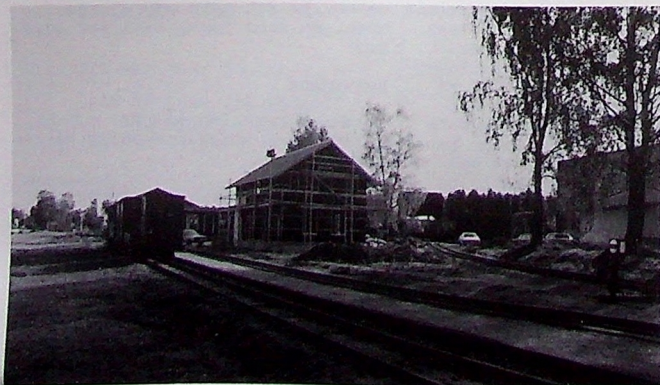
Høstens viktigste begivenhet var byggingen av stasjonsbygning i Sørumsand. Huset er ventet ferdig i mars 89, og er en kopi av Bjørkelangen stasjon. (E.Borghersen)
