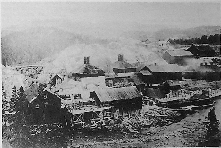
Smelteverket ved Songefossen.
