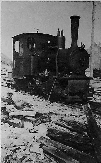
Lok nr. 1 på Topp Heis. (Tor Ulvund)
