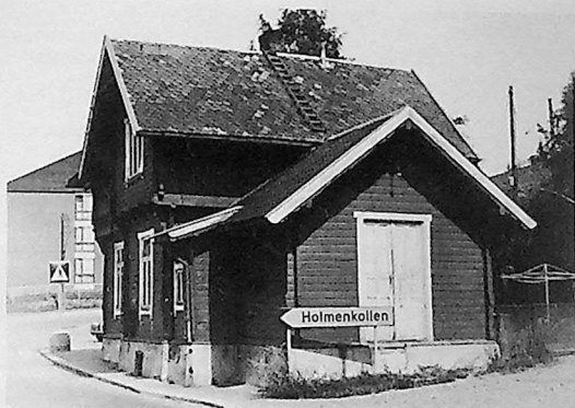
Stasjonsbygningen på Slemdal fotografert 24/7 1974.
