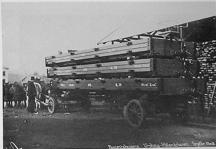
"Bogiestakevogne for Ursko g-Hølandsbanen. Septb. 1903." Vognene 38-40, med litra Q, fotografert ved leveransen. Bemerk bremserstolen på den øverste vognen. (Se også Tertittten nr. 44, s. 8 øverst)
