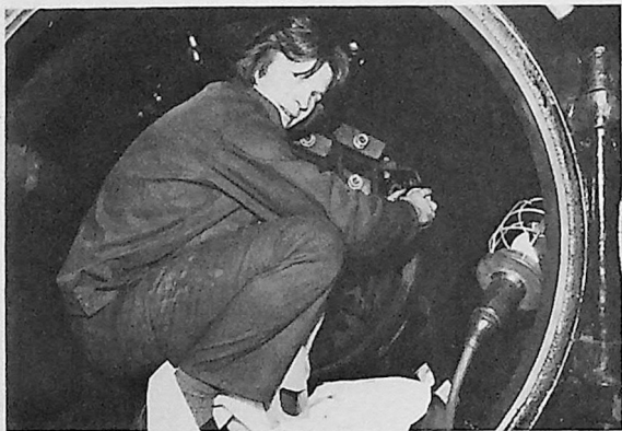
Roar Stenersen i ferd med å slipe linse- pakninger til kraftdamprøra.
