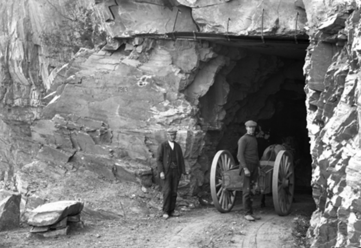
Tunnelen ved ytre Vastadneset. Menn og stuttkjærre foran tunellåpningen der årstallet 1913 er hogd inn.
