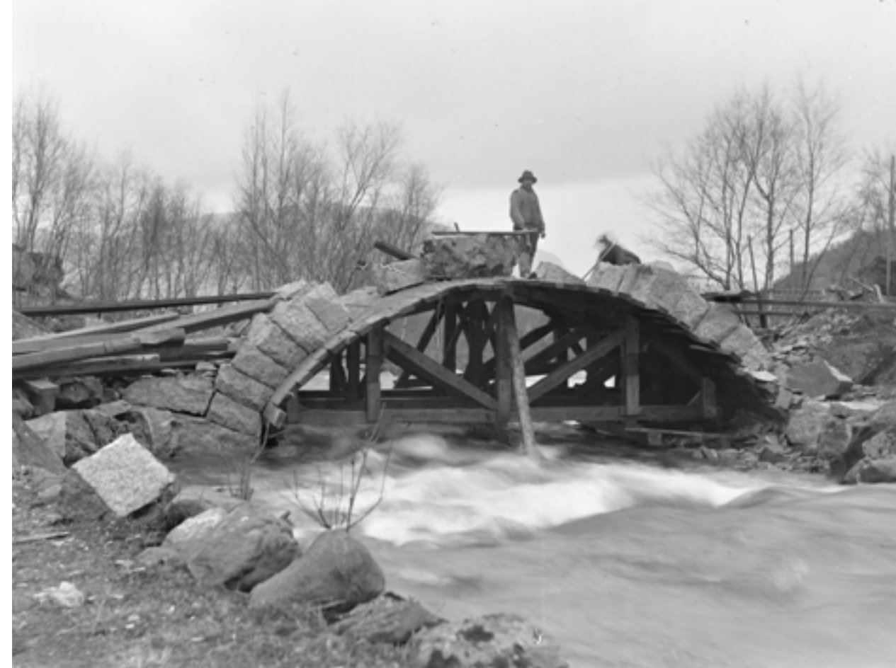
Anleggsarbeider på toppen av Hausken bru (Hjelmeland) med feisel i hånda, rallarhatt og busserull.
