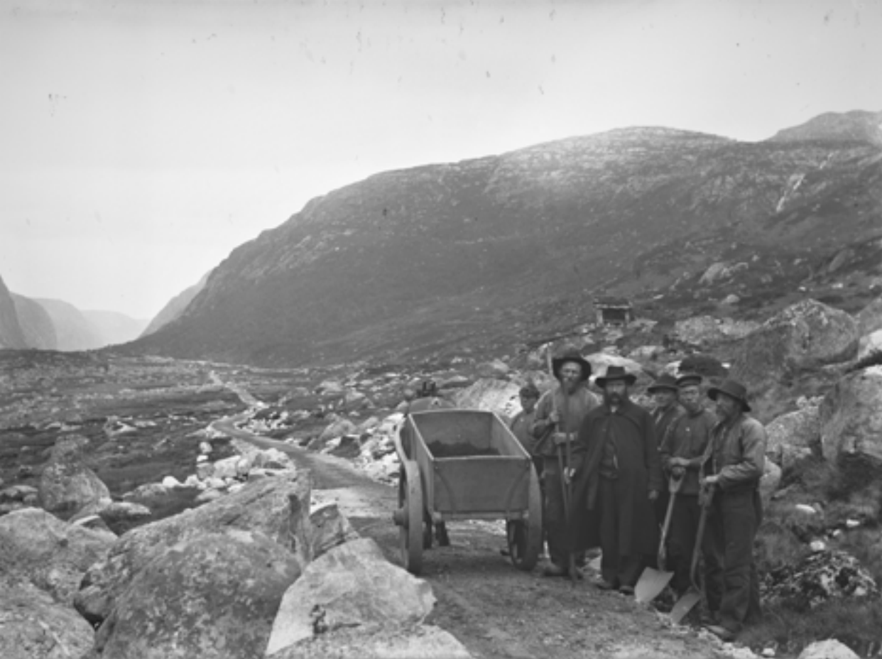
Oppsynsmann Sjur Aarthun er på inspeksjon på arbeidet med opprustning av vegen mot Byrkjedal.
