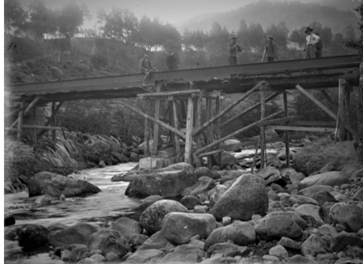
Arbeid med Tytland bru i Hjelmeland.
