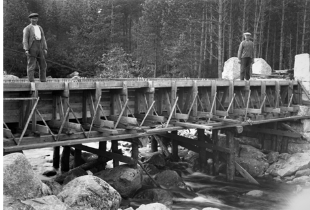
Laugaland bru under bygging ved hjelp av stillas i tre. Brua er trolig ei av de første bygd i armert betong.
