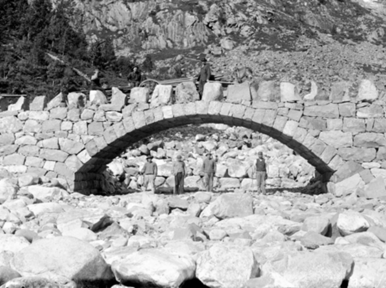
Stolte anleggsarbeidere ved Gya bru, Heskestad, etter ombygging.
