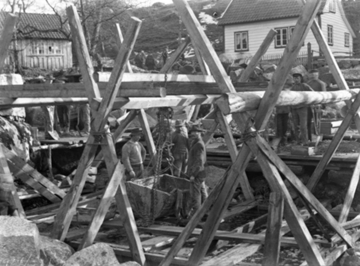
Gamle Hjelmeland bru under oppføring.
