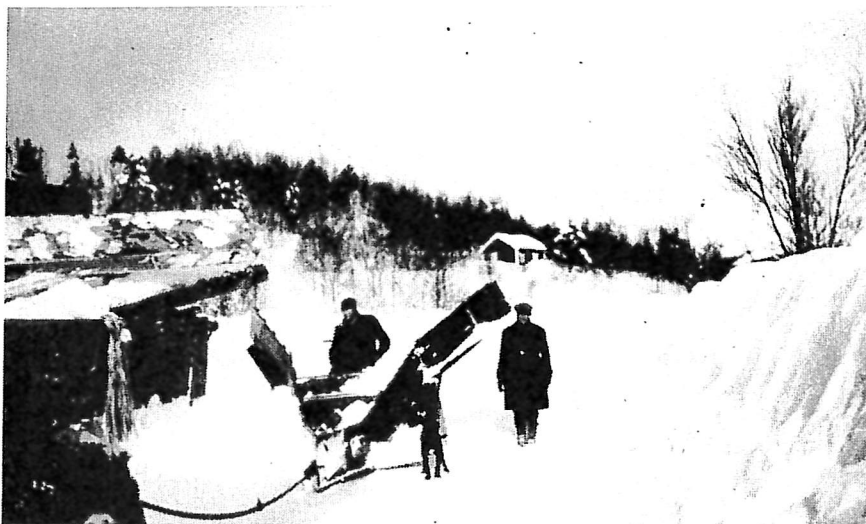
Frå opprømmingsarbeid på Batnfjordsfjellet.
