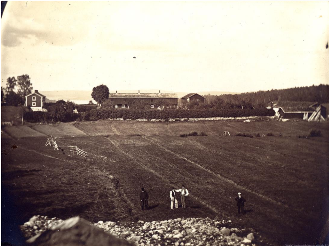
Bild från 1860-talet Anders Andersson med tre av sina söner på åkrarna söder om Siggebohyttans bergsmansgård. Gårdsbilden påminner om dagens. Parlönnarna står väl uppväxta framför mangården. Bakom drängstugan syns vad som troligtvis är början på allén samt ett större träd. Möjligen en björk. De två lönnarna som tidigare stått framför drängstugan har ännu inte tillkommit. Troligtvis planteras/släpps de upp omkring 1870. Syrenhäcken i söder samt stödmuren syns väl. Ovanför syrenhäcken, i den södra delen av trädgården, syns ett flertal fruktträd. Bild: Lindesbergs kulturhistoriska arkiv.
