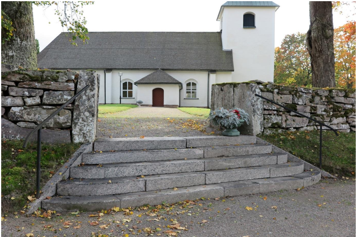
Huvudingång från norr utgörs av en trappa med granitsteg.
