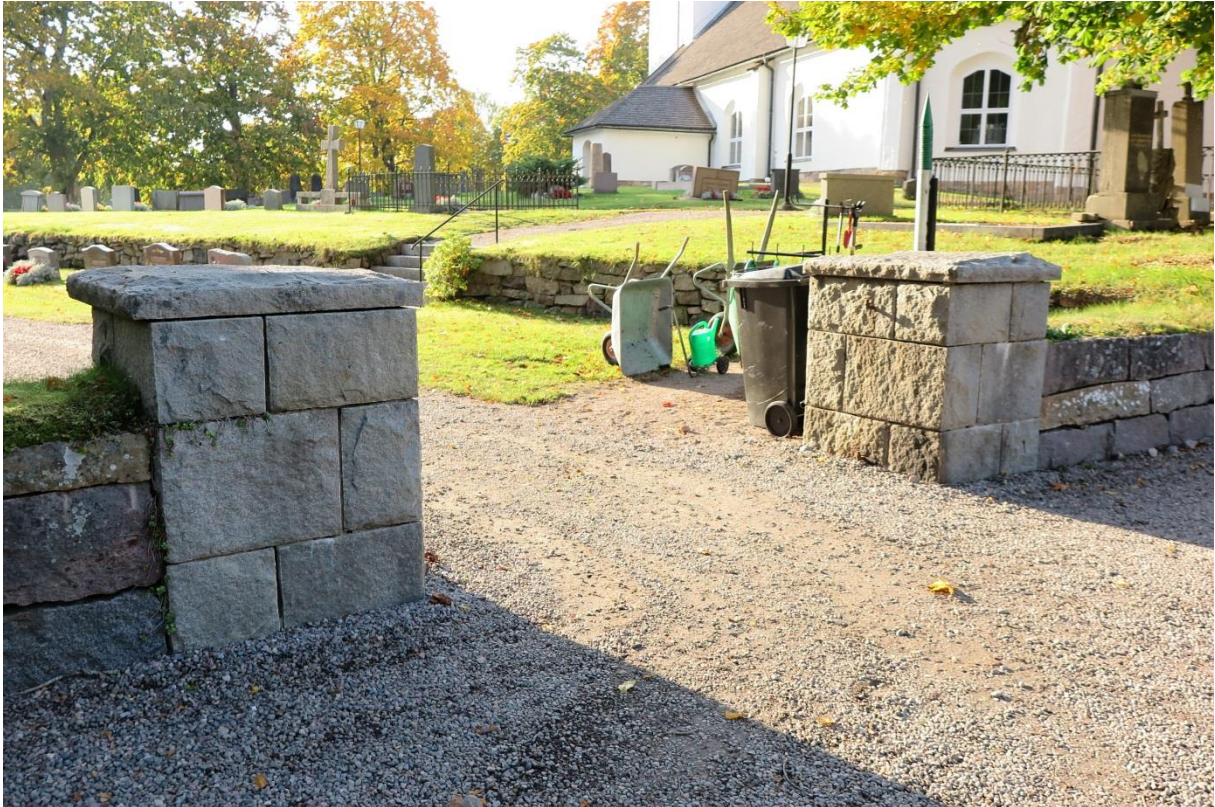
Entré i sydost till 1960-talets område söder om kyrkan. Här finns två kraftiga murade portstolpar avtäckta med flata stenskivor.
