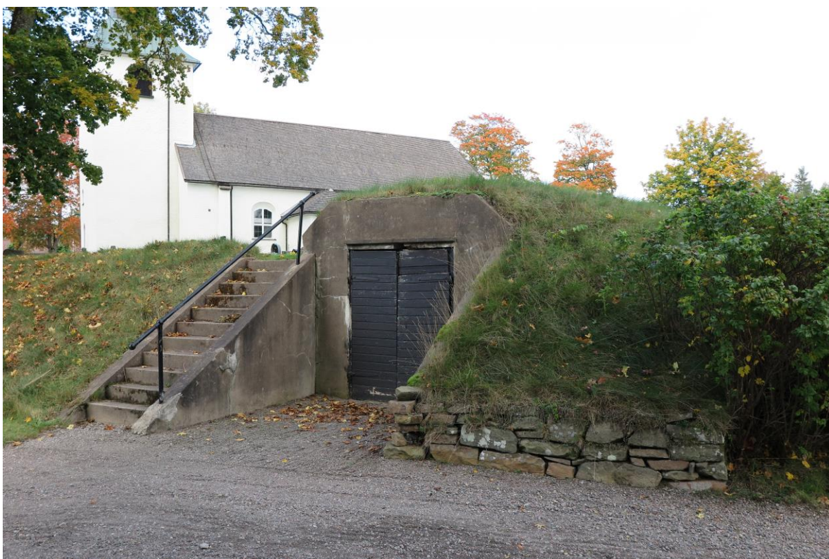
Bårhuskällaren sydväst om kyrkan är ingrävd i slänten till gamla kyrkogården. Förbindelse till det västra kyrkogårdsområdet ges via två gjutna trappor i slänten.
