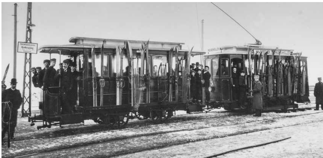
Holmenkoll-banen, anlagt i 1898, bidro til at hovedstadens innbyggere kom raskere ut i Nordmarka og de områdene Krag hadde vært med å utvikle. (Foto fra Norsk Folkemuseum)
