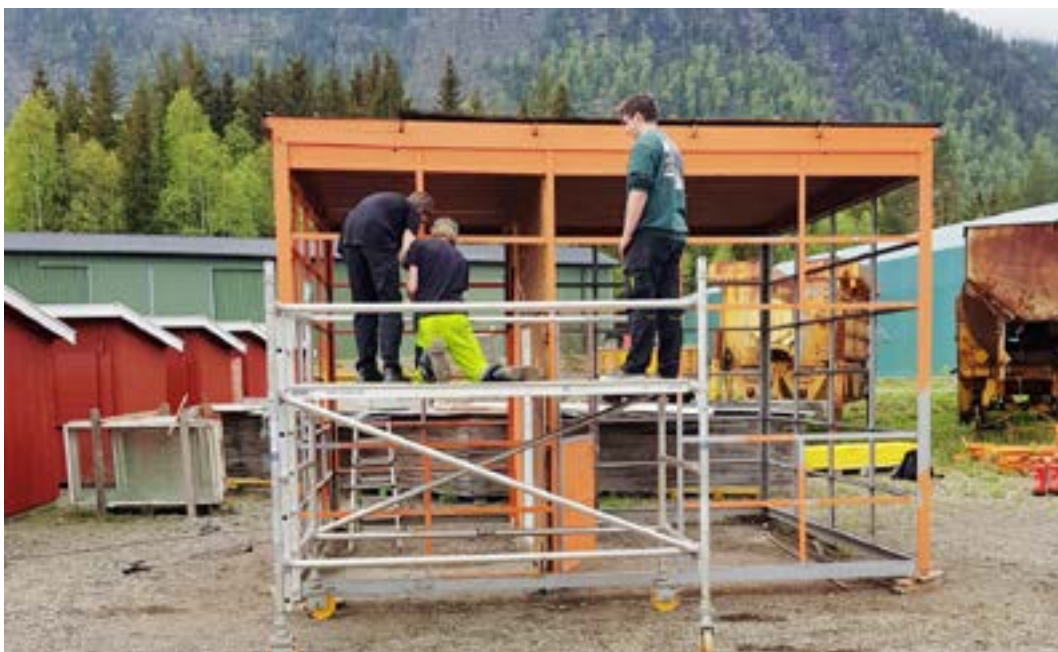
Elever ved Lillehammer videregående skole avdeling nord jobber med stålkonstruksjonene. (Foto: Ola Per Lotten)
