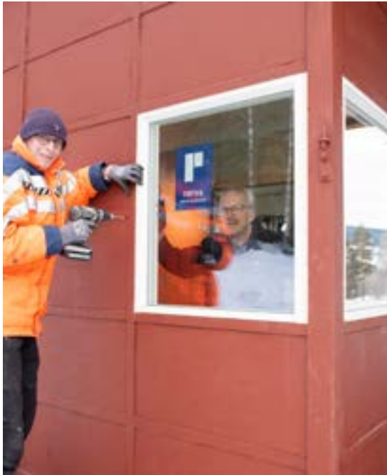
Dagfinn Sveen og Stein Erik Blomberg monterer nye vinduer på stasjonen. (Foto: Morten Reiten)
