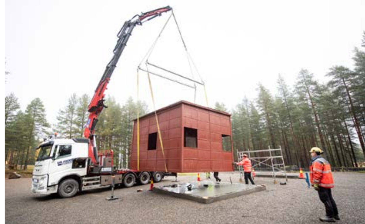
Ola-Per Lotten passer på at alt går riktig for seg når stasjonen heises på plass til sin nye tilværelse ved Norsk vegmuseum. (Foto: Morten Reiten)
