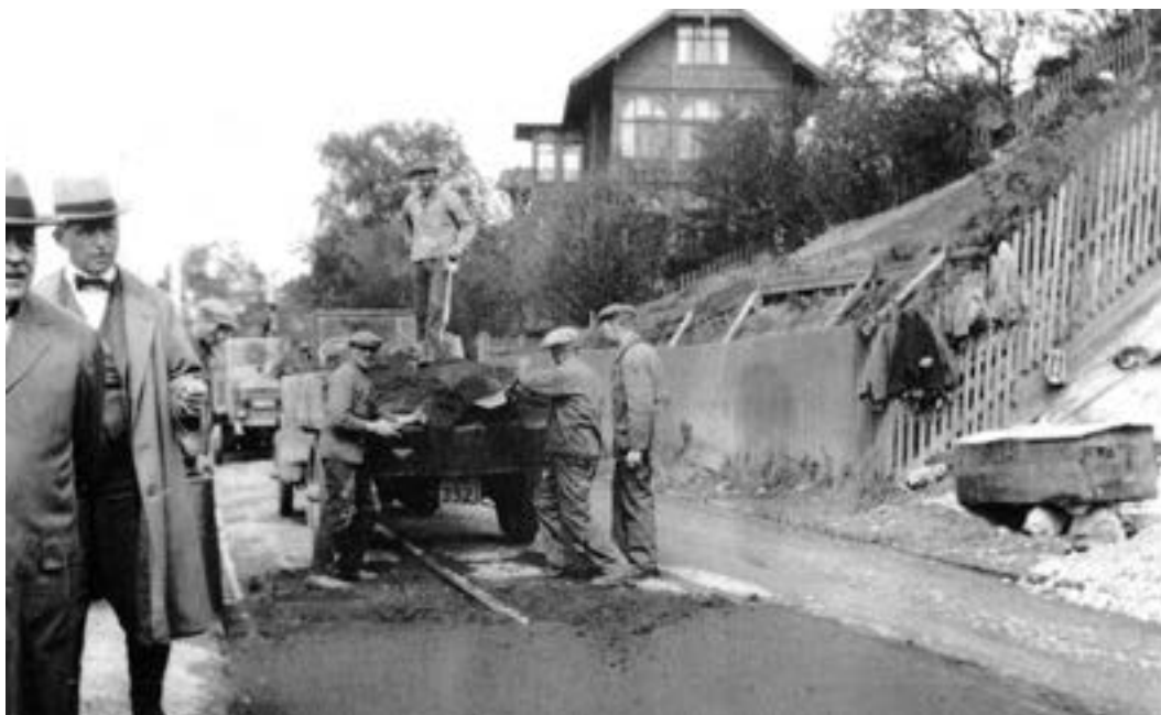
Vegsjefene i Østfold, Vestfold og Akershus fikk tidlig prøve ut faste dekker, og i Akershus var asfalt dominerende. Her prøveutlegging av fast dekke på Mosse eller Drammensveien i 1925-28.
