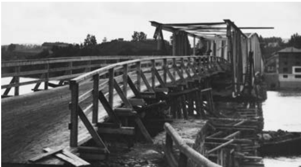
Den krigsskadede Sundbrua ved gamle Eidsvoll stasjon ble midlertidig reparert 23. juli 1940. Bildet er tatt av Karl Olsen, da avdelingsingeniør ved Akershus vegkontor, senere vegdirektør fra 1962-80.
