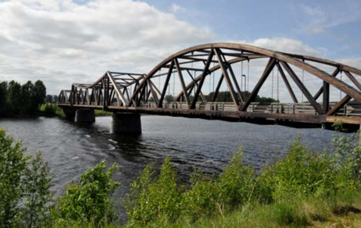
Flisa bru i Hedmark ble bygd i 2008 og erstattet da en gammel stålbru fra 1911. Den er priset som en av de vakreste trebruene i landet. (Foto: Håkon Aurlien)
