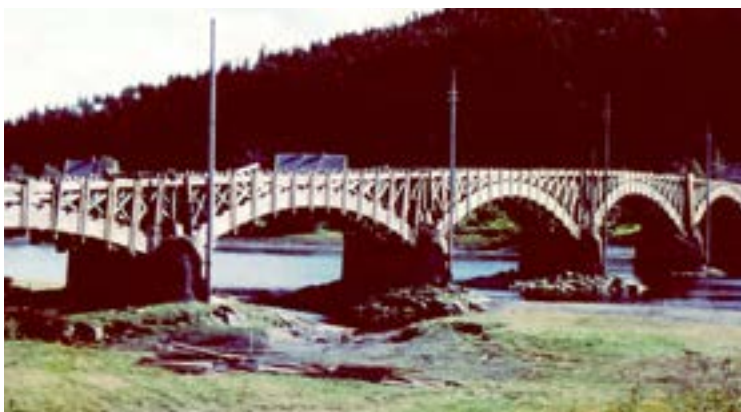
Sandfjørhus bru under riving etter at den var tatt ut av bruk i 1958, 102 år gammel.
