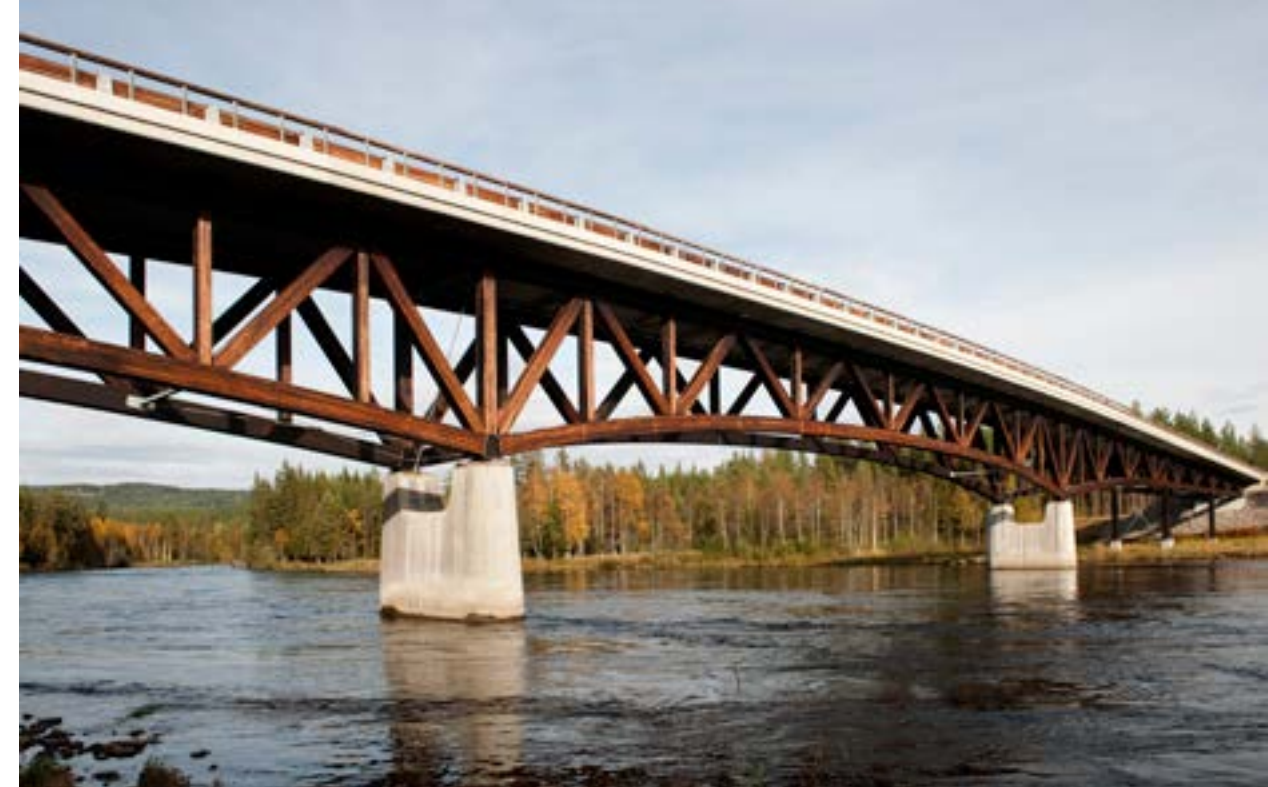
Kjøllsæterbrua er en fagverksbru i tre med betongdekke. Den er bygd for at tunge militære beltegående kjøretøy skal kunne benytte den. (Foto: Rune Abrahamsen, Moelven limtre)
