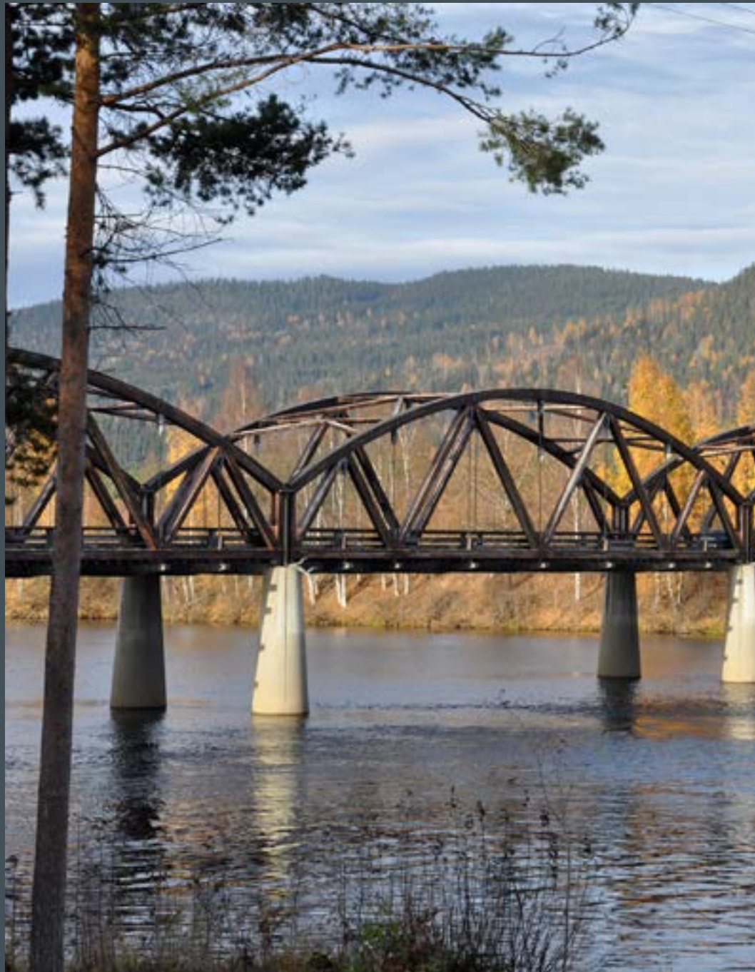
Evenstadbrua i Østerdalen er en av de første moderne trebruene som er bygd i Norge. Brua sto ferdig i 1996. Den er 180 meter lang, fordelt på fire buekonstruksjoner. (Foto: Håkon Aurlien)
