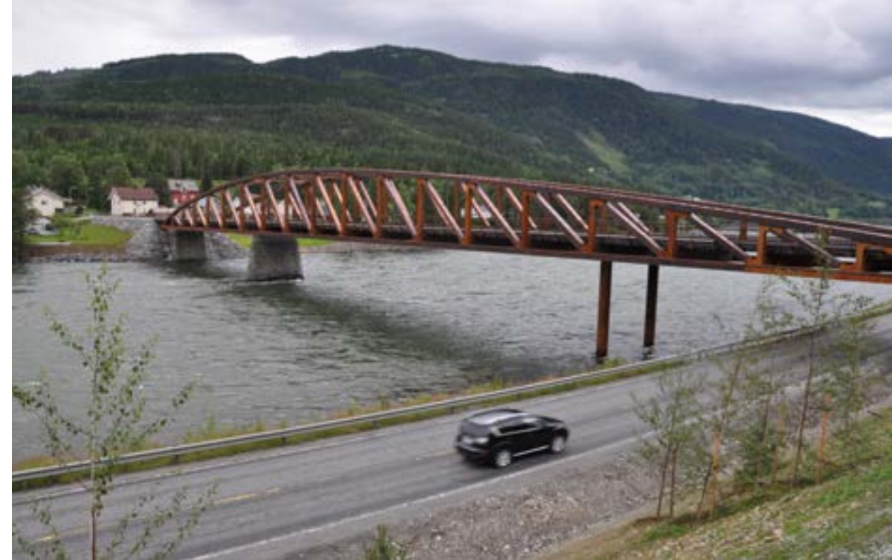
Tretten bru over Gudbrandsdalslågen og E6 ble bygd i 2011 og erstattet da en gammel stålbru. Den er formet som en flyinge eller fisk og bygd i samvirke mellom tre og rusttregt stål. (Foto: Håkon Aurlien)
