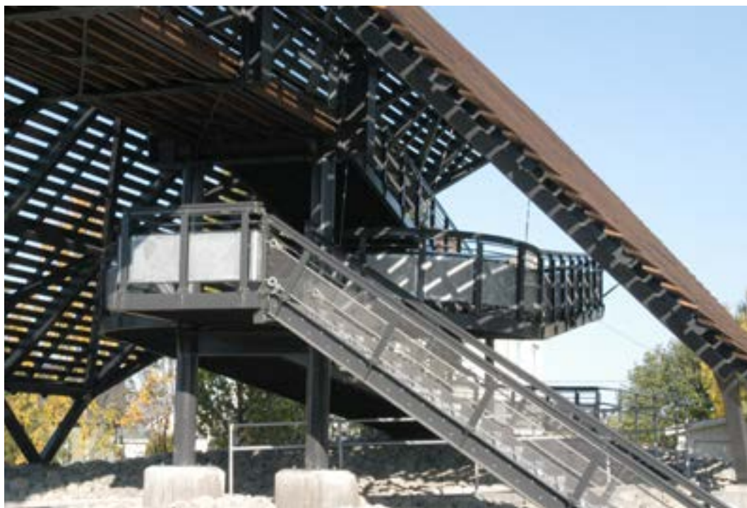
I Alta i Finnmark er det laget et fint samvirke av stål og treverk i en fotgjengerovergang over E6 (Foto: Håkon Aurlien)
