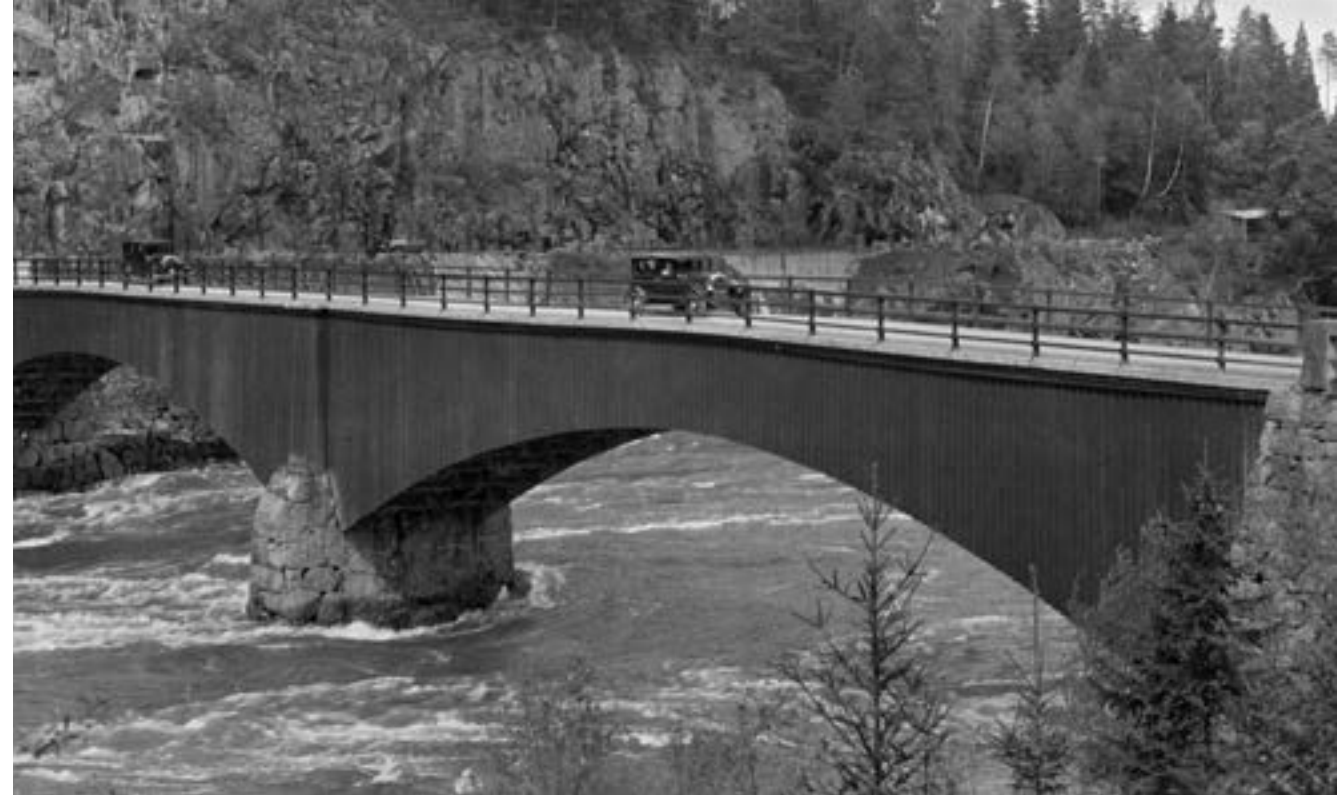
Fossum bru fra 1856. fotografert av Anders Beer Wilse i 1933. Brua ble krigssprengt i 1940 men løftet seg og falt ned igjen med store forskyvelser, ikke mer enn at den kunne brukes forsiktig frem til 1944. En hengebru ble så spent over, og begge tatt bort i 1962. (Foto fra Norsk Folkemuseum).
