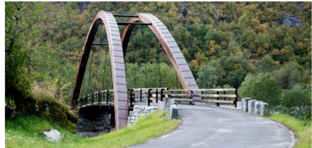
Ner Hole bru i Romsdalen, lokalt kalt Romsdalsporten bru. (Foto: Otto Kleppe)
