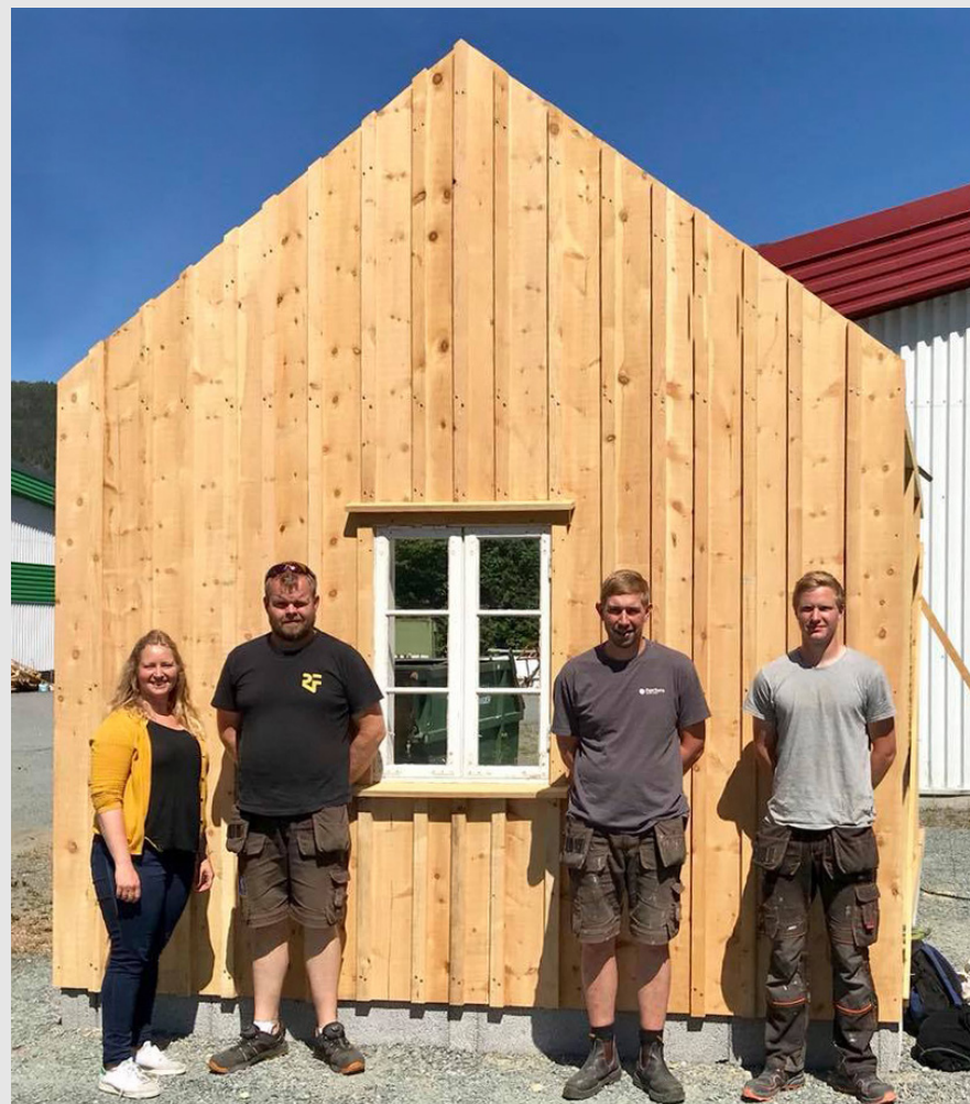
Foto: Lærling ved Ryfylkemuseet, Ådne Jordebrekk Fermann, tok sveinebrev i 2018. Prøva gjekk ut på å konstruera - med vinklar og innfellingar - ein gavl, og å kle den med ståande kledning. Her står Ådne (t.h.), etter vel bestått sveineprøve, saman med (f.v.) Stina Ekelund Erlandsen, Kjell Gunnar Haraldseid og Sven Hoftun.
